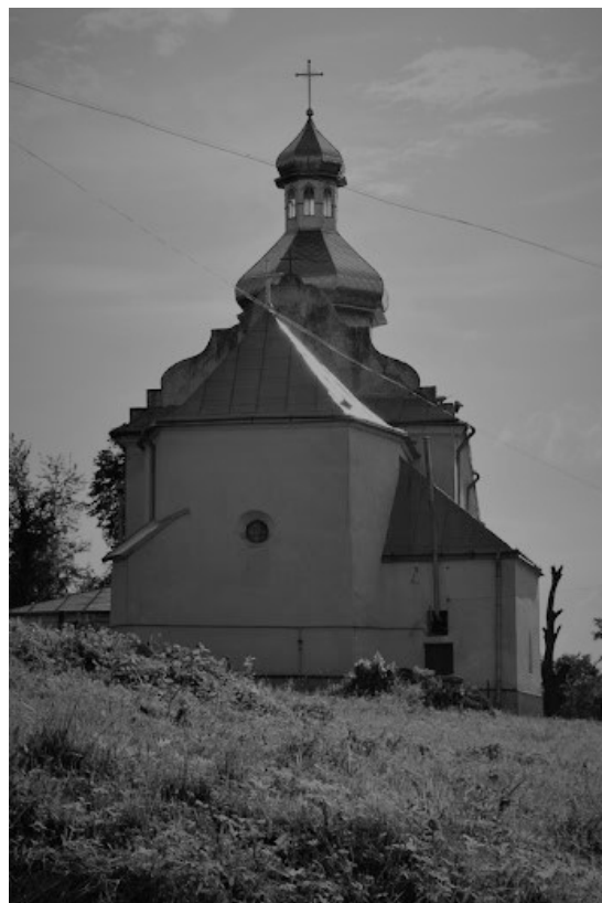
Kościół pw. św. Stanisława (obecnie cerkiew grekokatolicka), fot. T. Klimaszewicz
