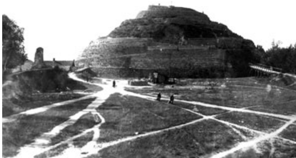
Wysoki zamek w trakcie budowy
