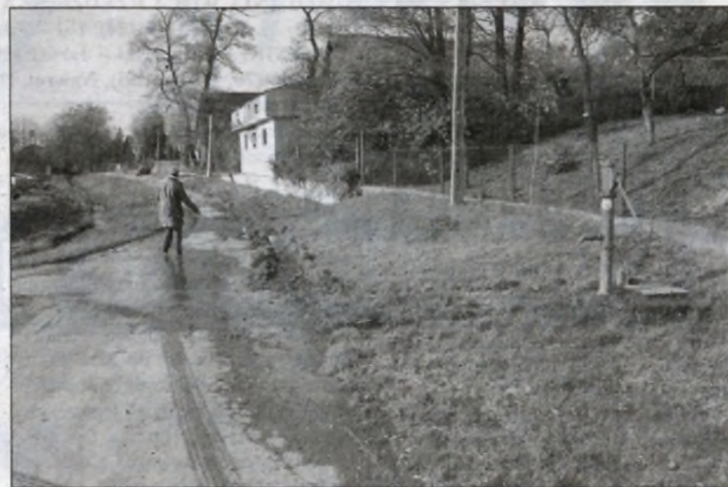
Wiesławie Zboroch marzy się modernizacja wału przeciwpowodziowego i budowa na jego koronie ścieżki rowerowej, która prowadziłaby z Niepolomice do Krakowa.
