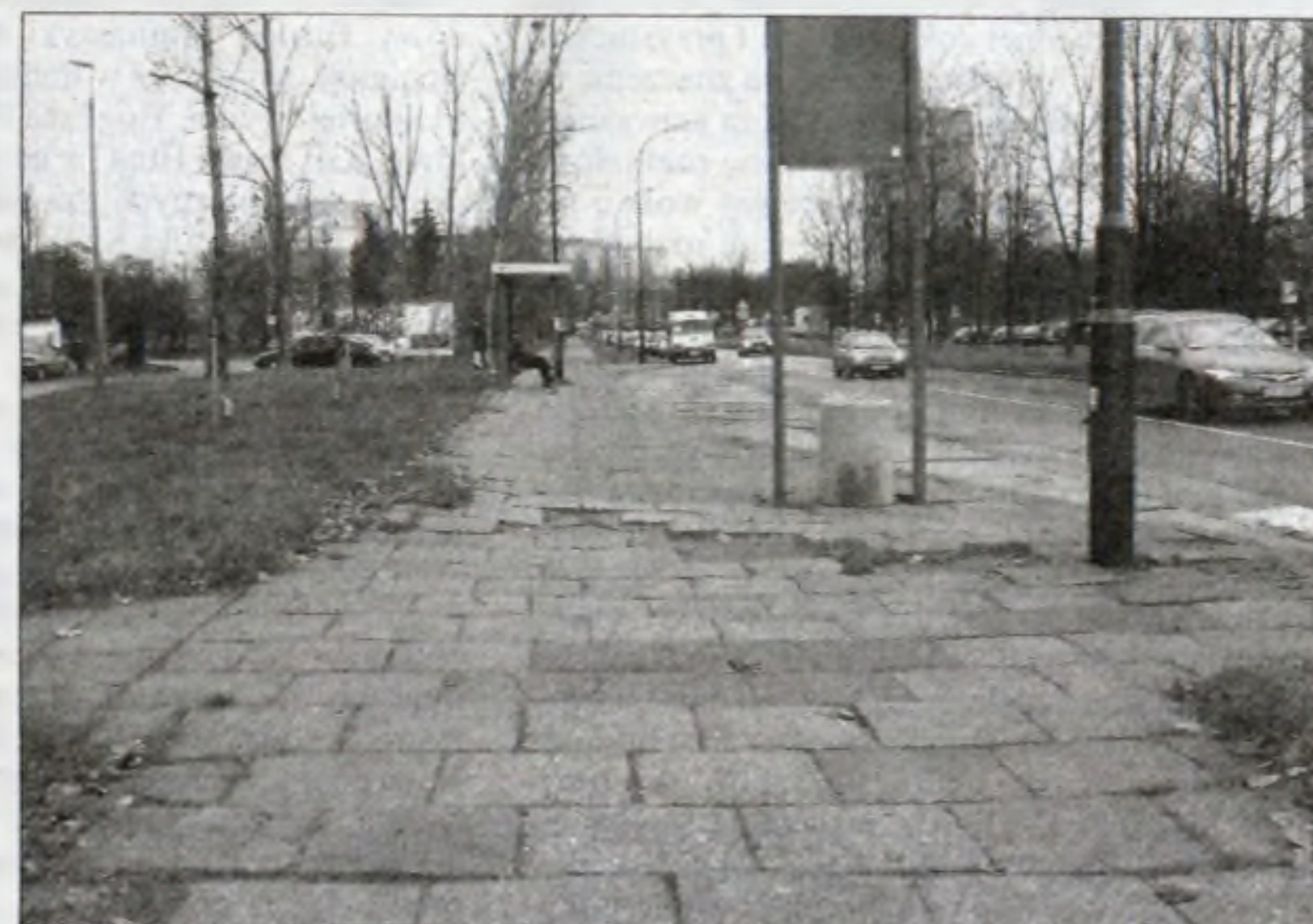
Przy ul. Marii Dąbrowskiej zniknie fatalna nawierzchnia a pojawi się ścieżka rowerowa i chodnik z kostki brukowej.
