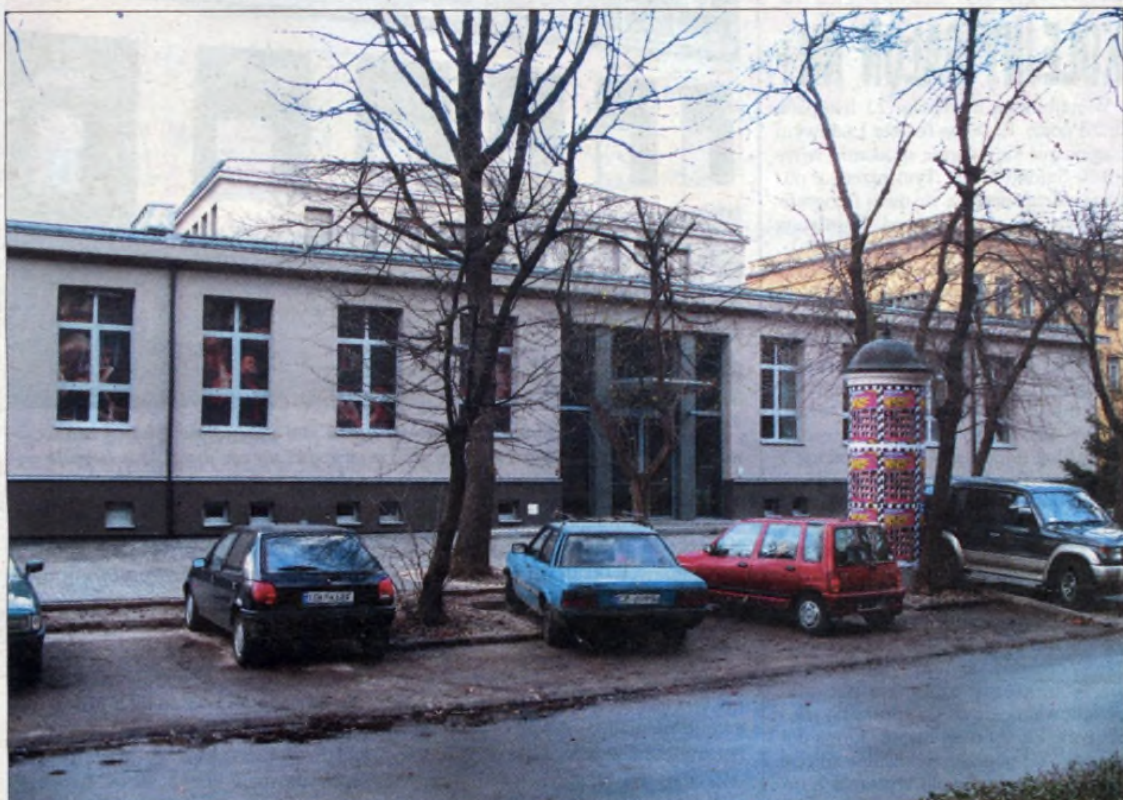
Trwają prace remontowo-modernizacyjne budynku Teatru Łaźnia Nowa na os. Szkolnym.
