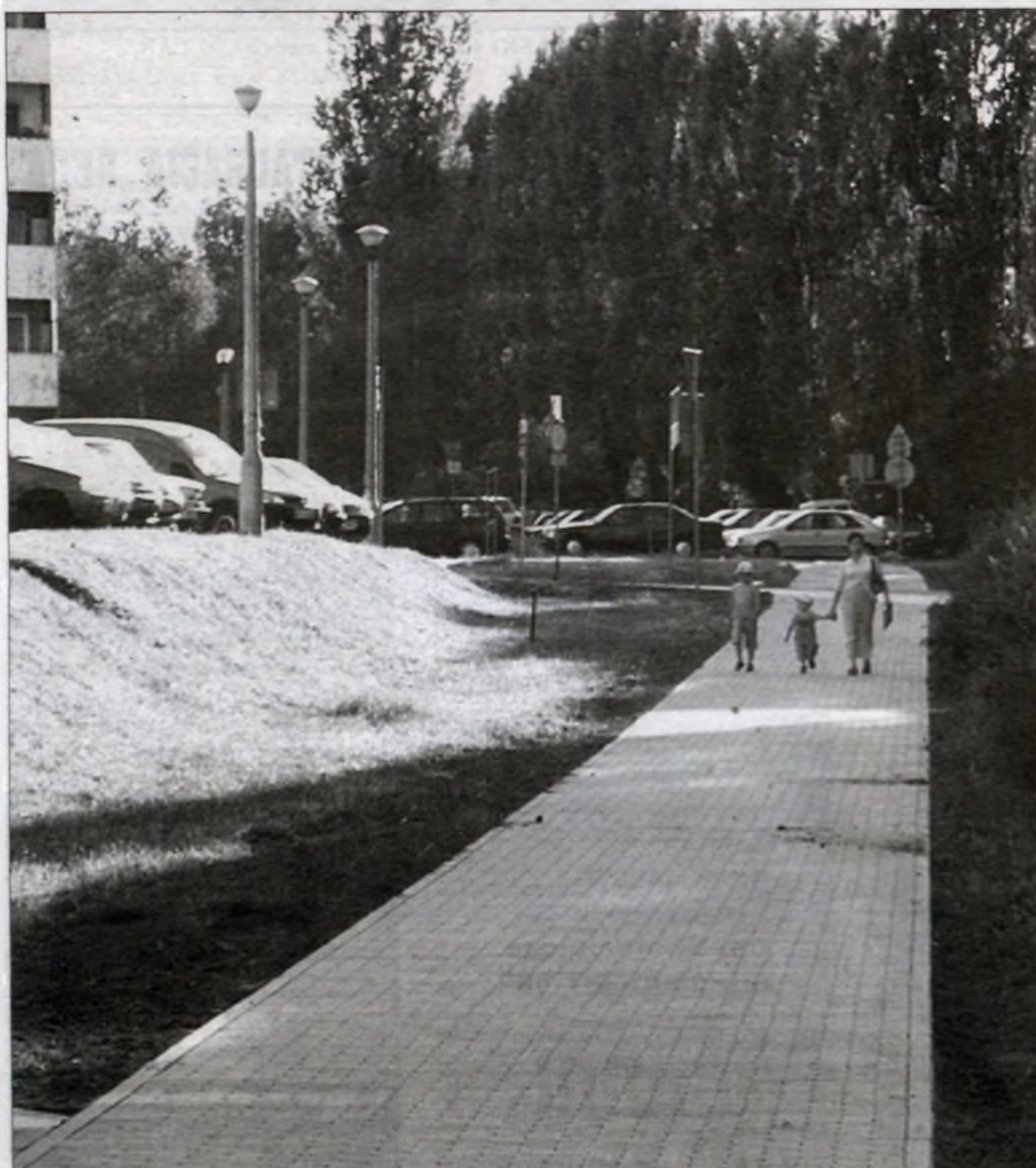
Nowy chodnik wzdłuż bloku nr 1 w os. Bohaterów Września.
