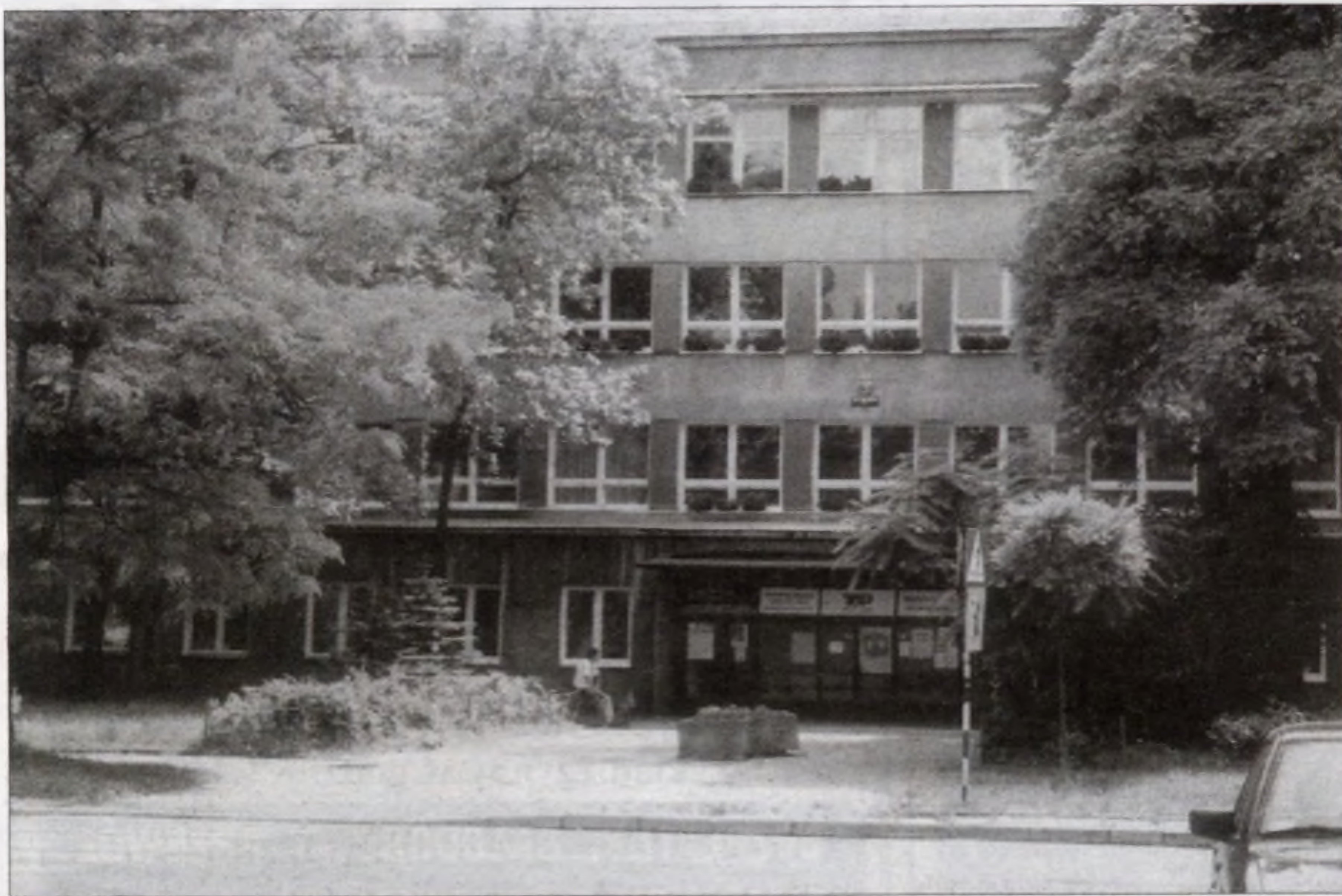
Szkoła Podstawowa nr 88 na Szklanych Domach dzięki pomocy Rady Dzielnicy XVIII wykonała gruntowny remont dachu.
