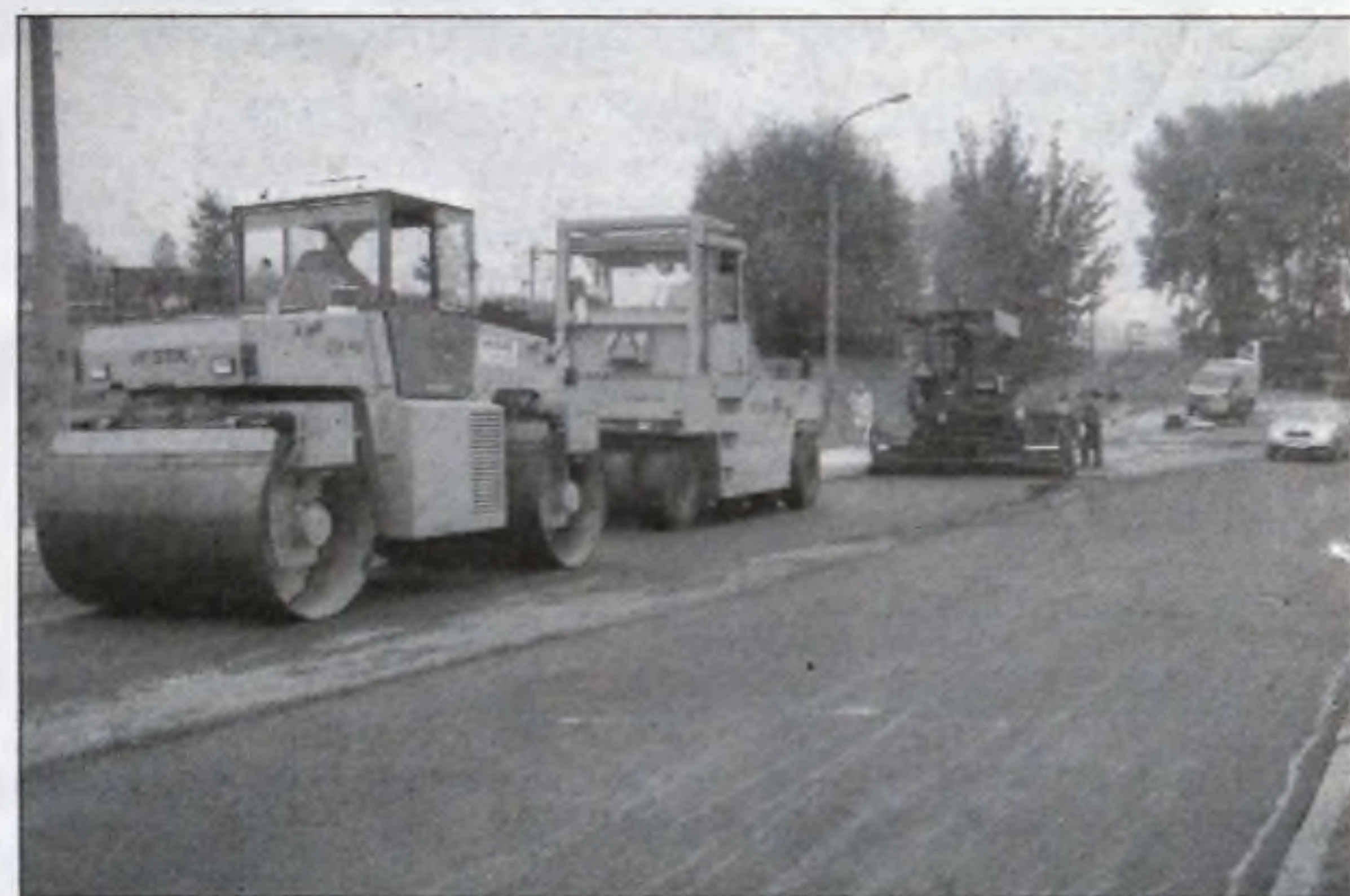
Nowy asfalt na ul. Bohomolca.
