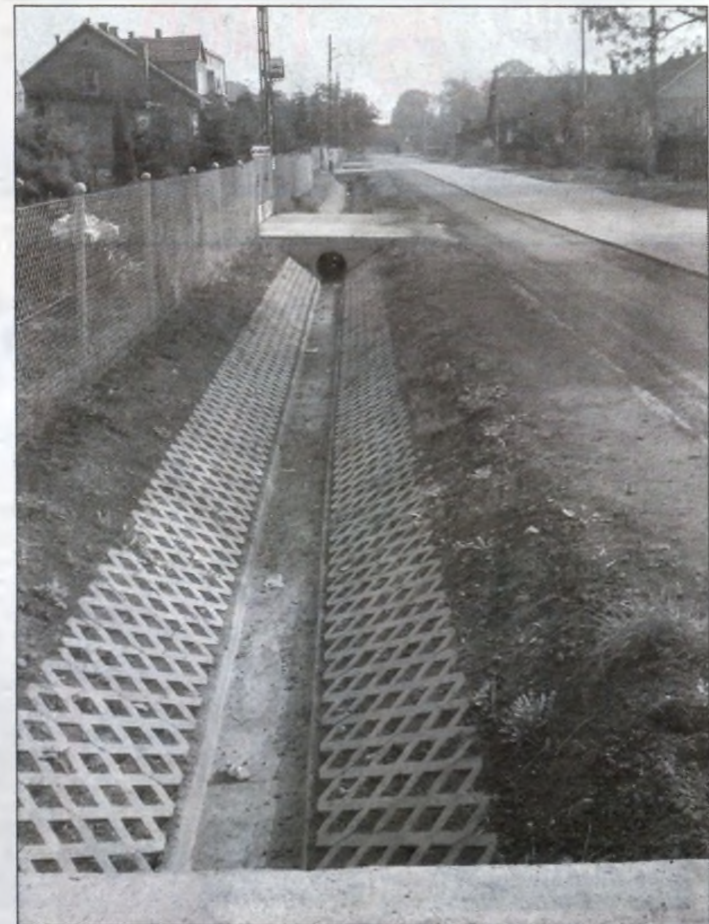
Odwodnienie ulicy Wyciąskiej.
