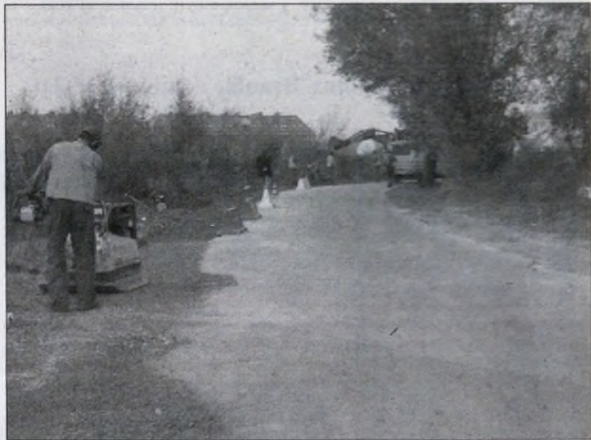
Prace przy poszerzaniu tymczasowego połączenia.
