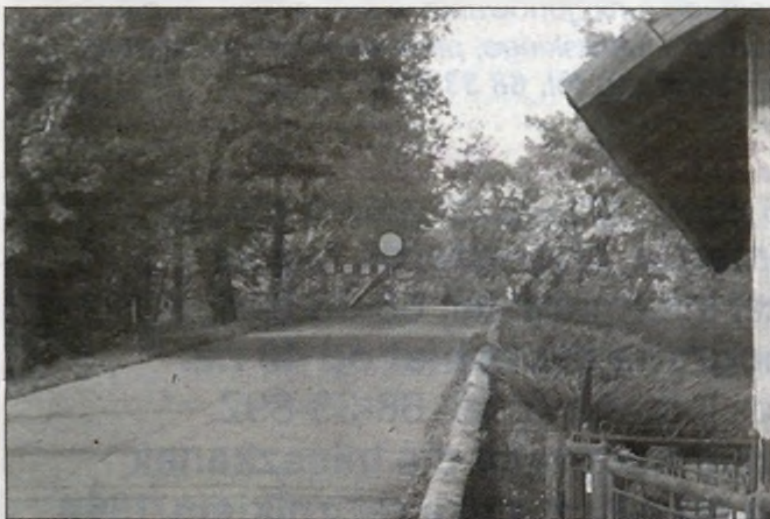
Budowa nowego mostu ruszy, jeśli ZDiK zaplanuje budowę chodnika po prawej stronie ulicy, w bezpośrednim sąsiedztwie położonego tutaj domu.
