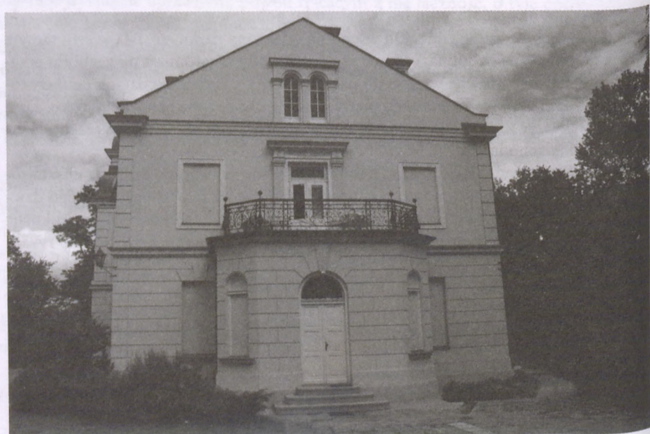
Ryc. 31. Elewacja południowa pałacu (fot. T. Ścieżor).
