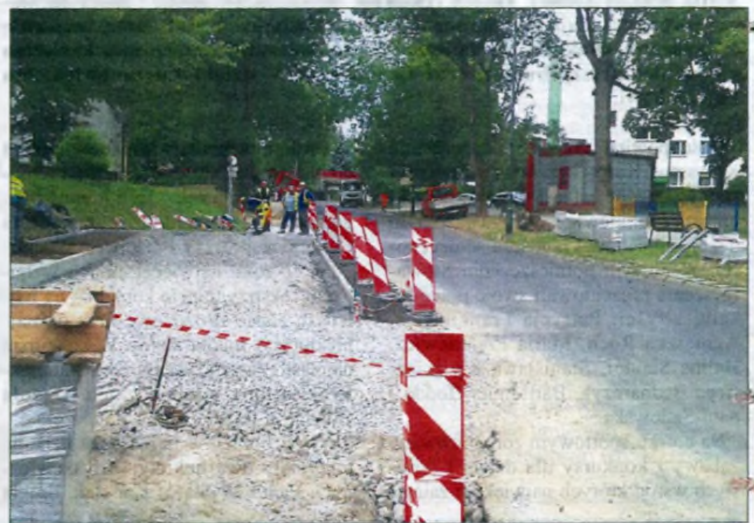
Remont ul. Cienistej.
