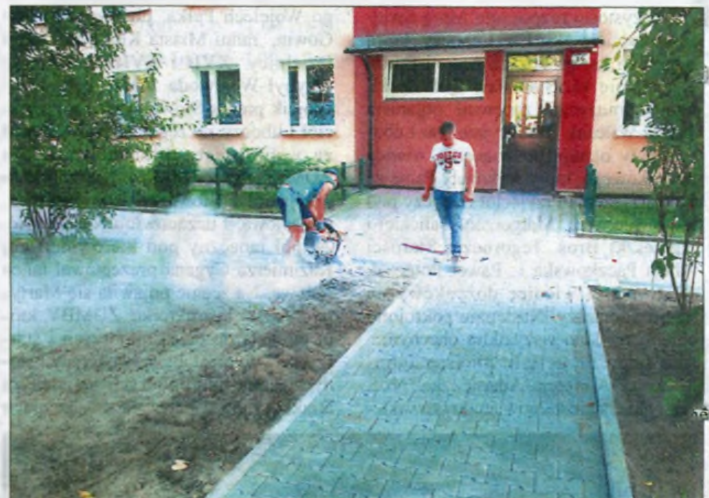
Remont łączników na os. Albertyńskim 16.
