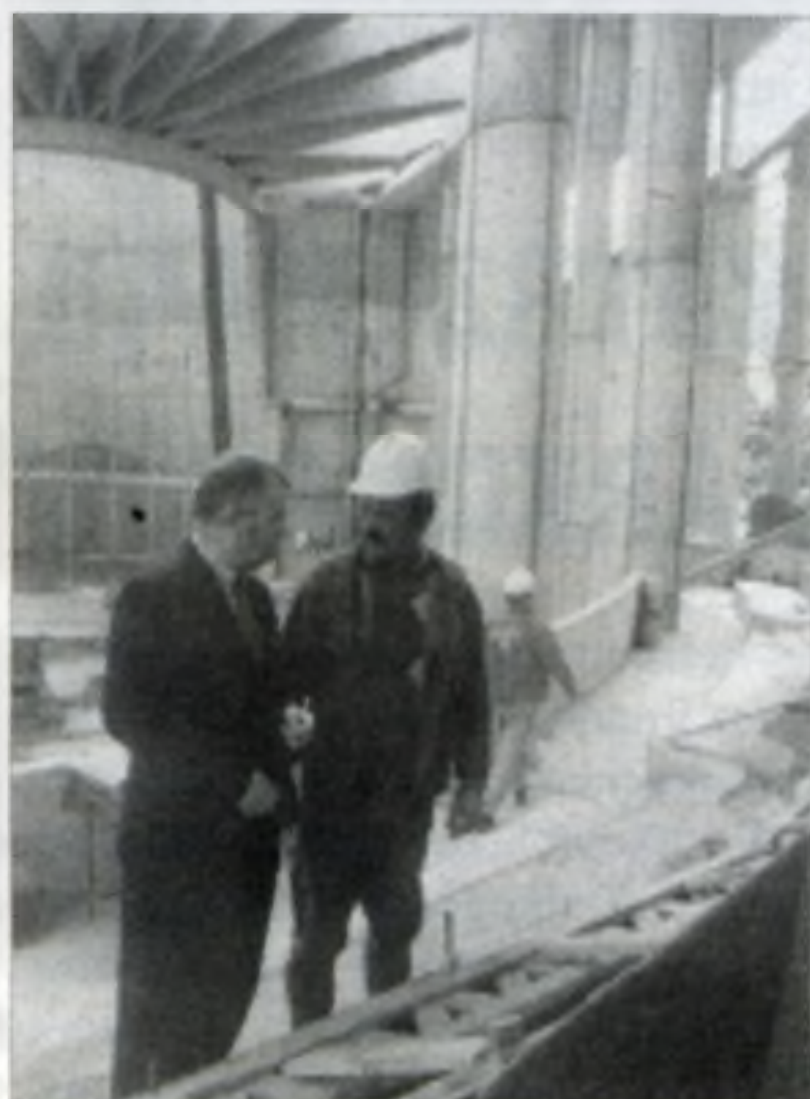
W trakcie prac budowlanych.
