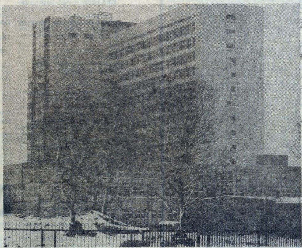
Ostateczny termin zakończenia robót budowlanych przewidziano na koniec 1987 r. Fot. Stanisław Gawliński
