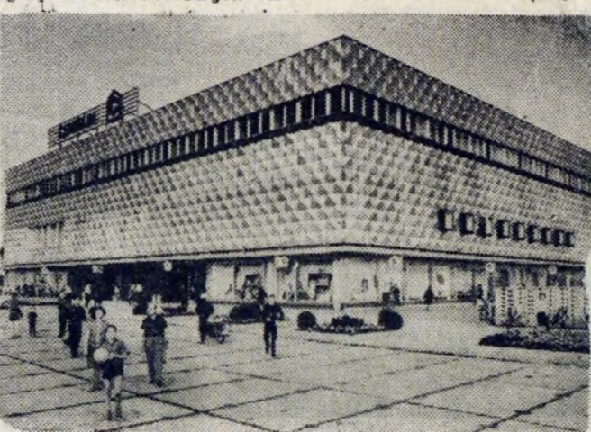
Ciekawa jest fasada aluminiowa otwartego w 1968 r. centralnego domu towarowego w małym miasteczku Hoyerswerde.
