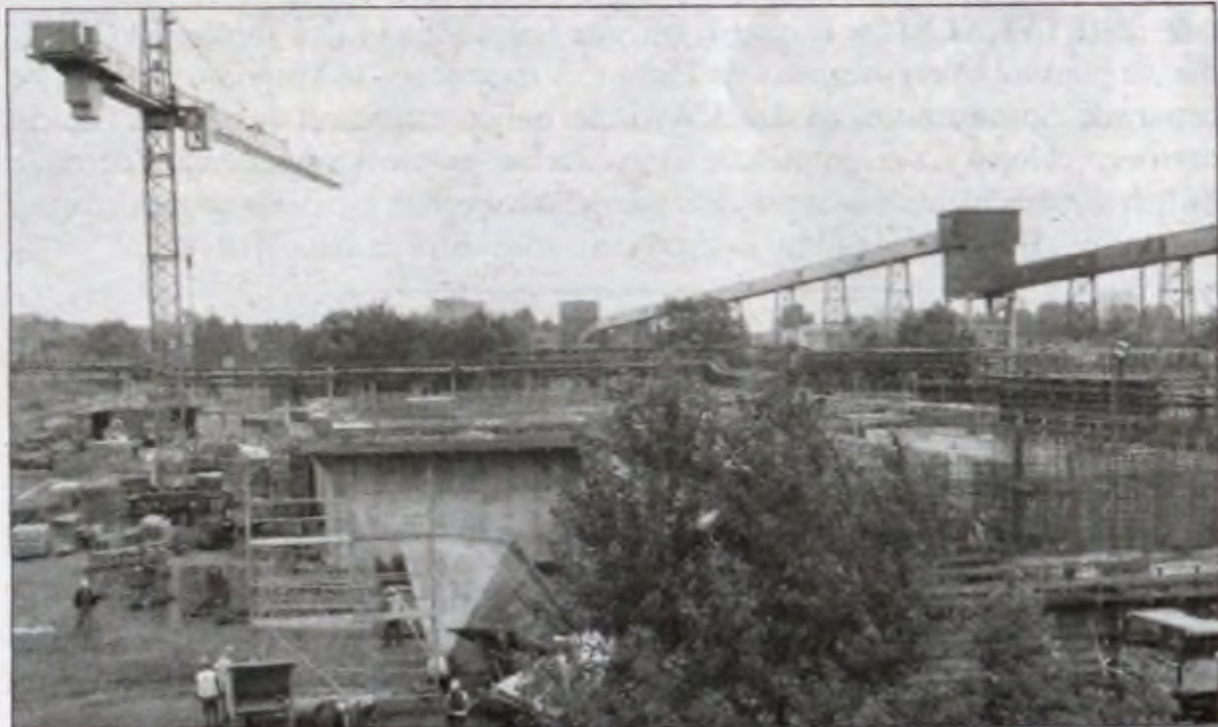
W krakowskiej koksowni ArcelorMittal Poland powstaje nowoczesna oczyszczalnia wód z procesu koksowniczego.
