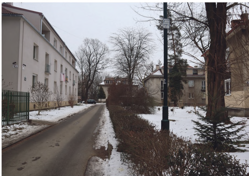
W os. Krakowiaków pomiędzy blokami 23 i 24 powstaną nowe miejsca postojowe.
