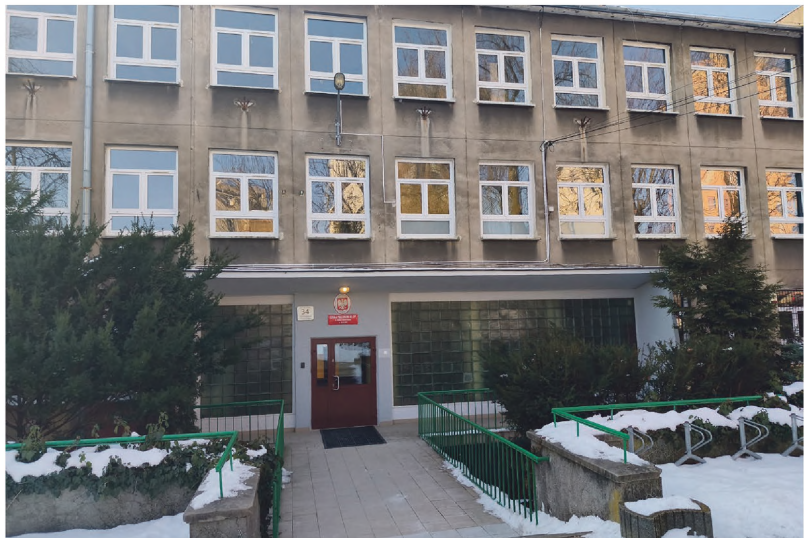
Przy Szkole Podstawowej nr 129 w os. Na Stoku 34 rozpoczną się prace przy budowie krytej pływalni.
