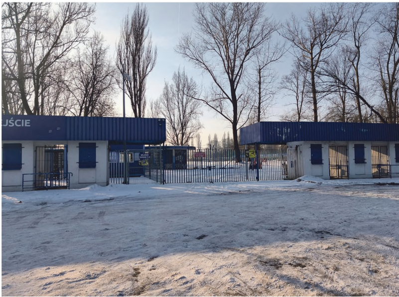
Na Miejskim Stadionie KS „Hutnik” rozpocznie się przebudowa.
