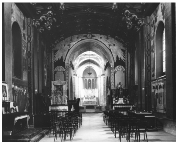
Wnętrze Katedry Ormiańskiej, Lwów (1938) – domena publiczna
