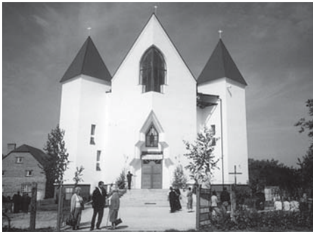
Nowy kościół rzymskokatolicki w Brodach, który ma zastąpić stary, zabytkowy, zamieniony na cerkiew
