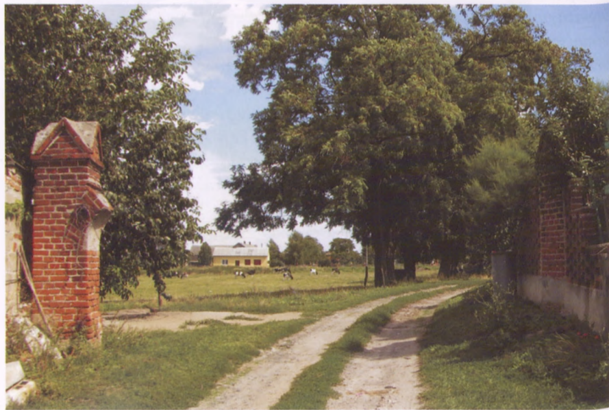
Aleja dojazdowa do folwarku w Tomisławicach z zachowanymi ceglаныmi słupami i murem - pozostałość po bramie wjazdowej, fot. Grażyna Fijałkowska
