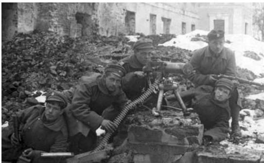
Pałac Siemieniuch-Lewickich – obrońcy Lwowa 1918 – domena publiczna.jpg
