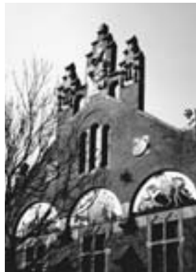
Budynek krakowskiego „Sokoła”
