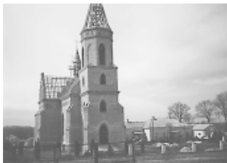
Budowa nowego kościoła w Skalacie (stan z maja 1999)
