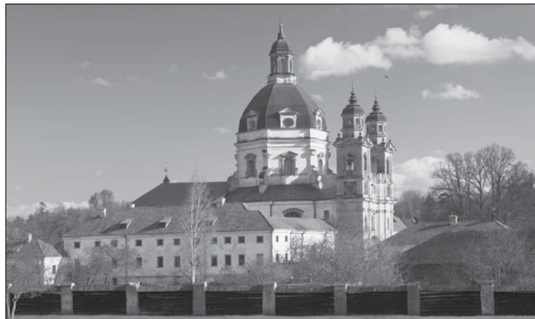
Widok na klasztor Kamedułów w Pożajściu k. Kowna
