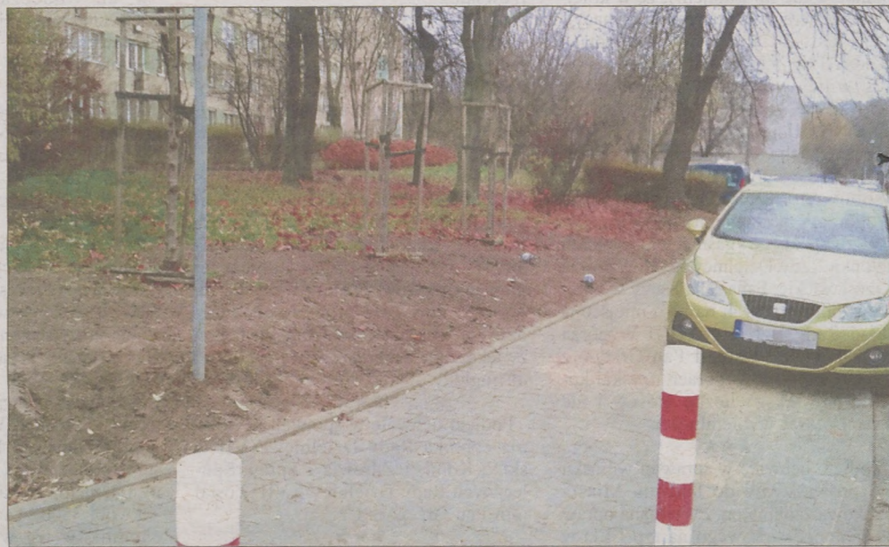
Remonty chodników w os. Kazimierzowskie przy ul. Andegaweńskiej.
