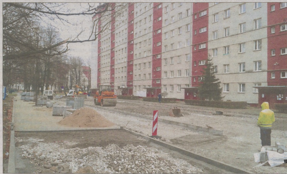
Remont ulicy Celakówny wraz z parkingiem przy bloku nr 6 w os. Strusia.
