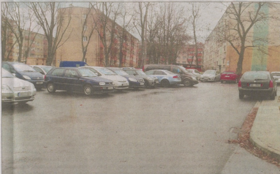
Remont parkingu, os. Albertyńskie przy blokach nr 24 i nr 29.
