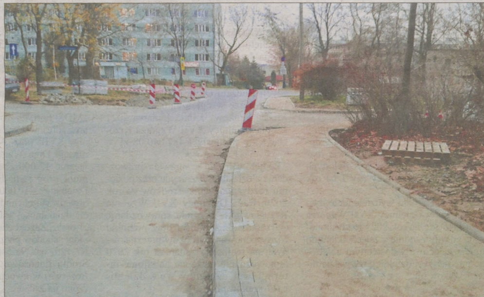
Remont ul. Królowej Bony w rejonie bloku nr 21 w os. Jagiellońskim.
