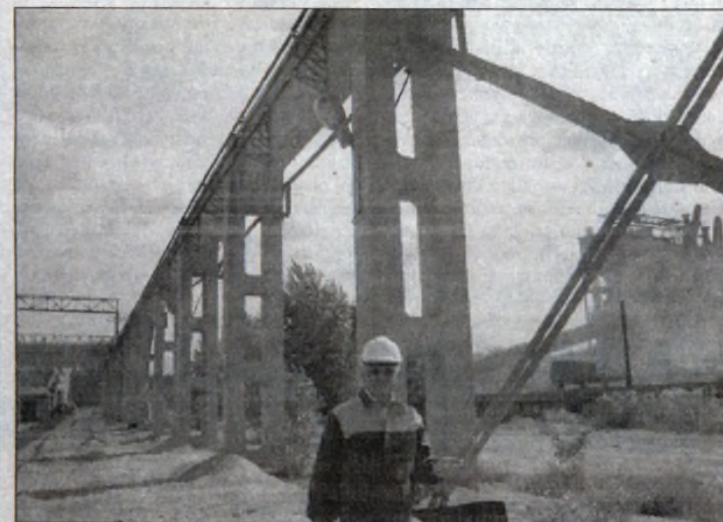
Gotowa do pracy, wyremontowana nakładem kilku milionów zł, instalacja granulacji żużla czeka na uruchomienie wielkiego pieca nr 5.
