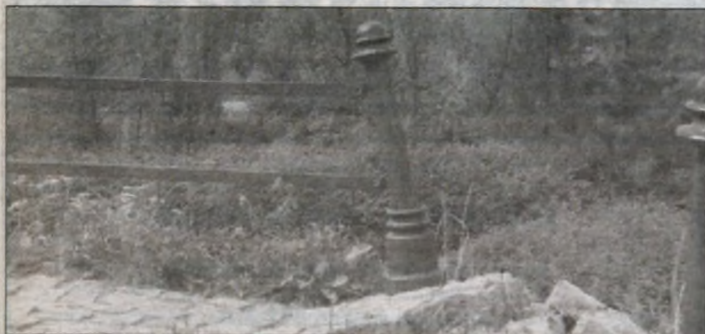
Z powodu zniszczeń nawierzchni naruszone zostały również metalowe bariery ochronne.
