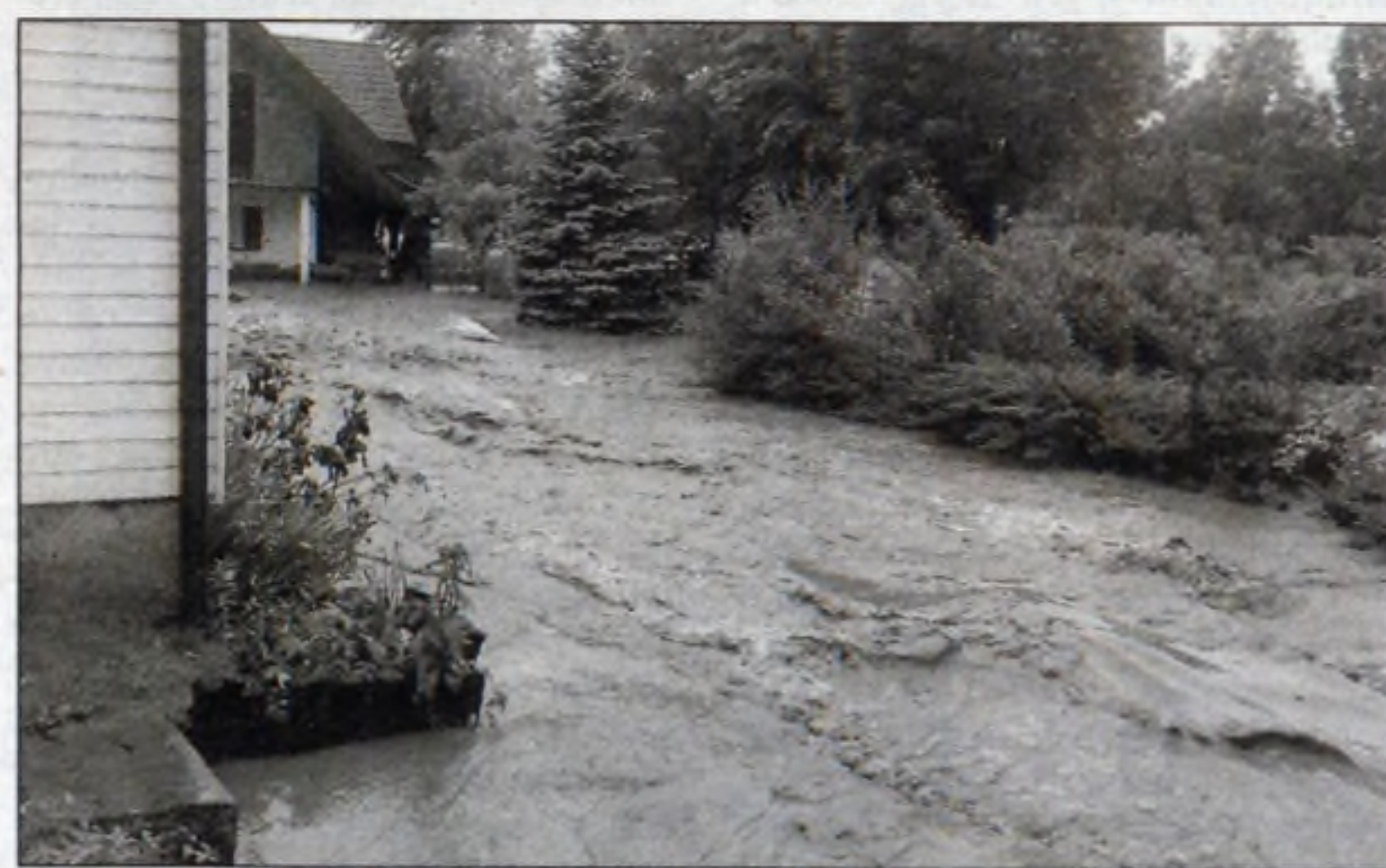
Ulica Pysocice – woda wdziera się na podwórkę.
