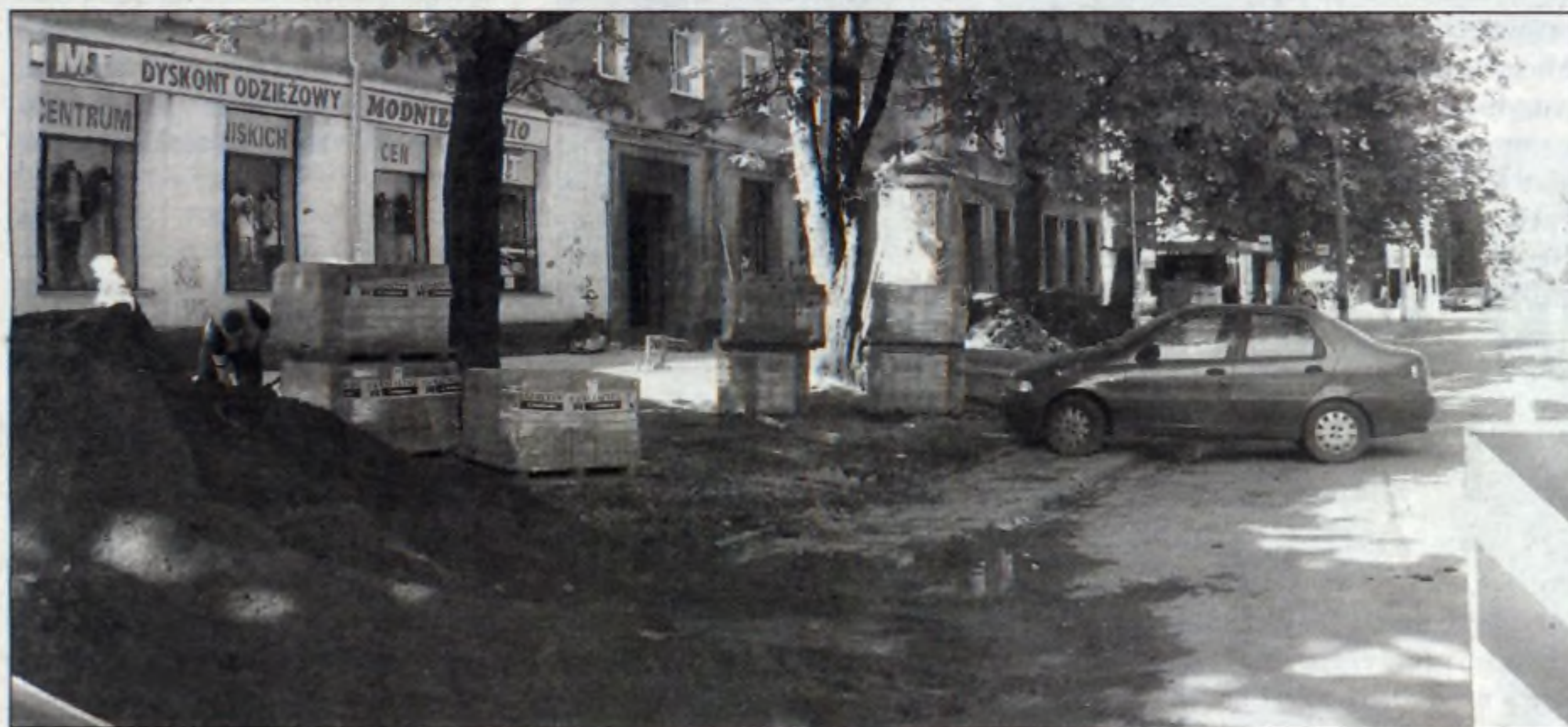
Budowa chodnika z kostki brukowej od strony al. Przyjaźni.
