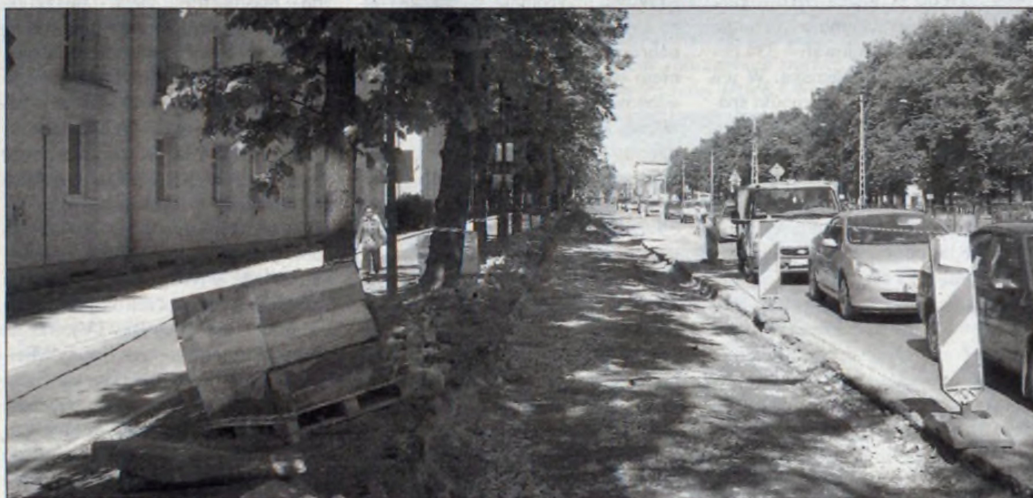
Budowa zatok parkingowych przy al. Jana Pawła II.
