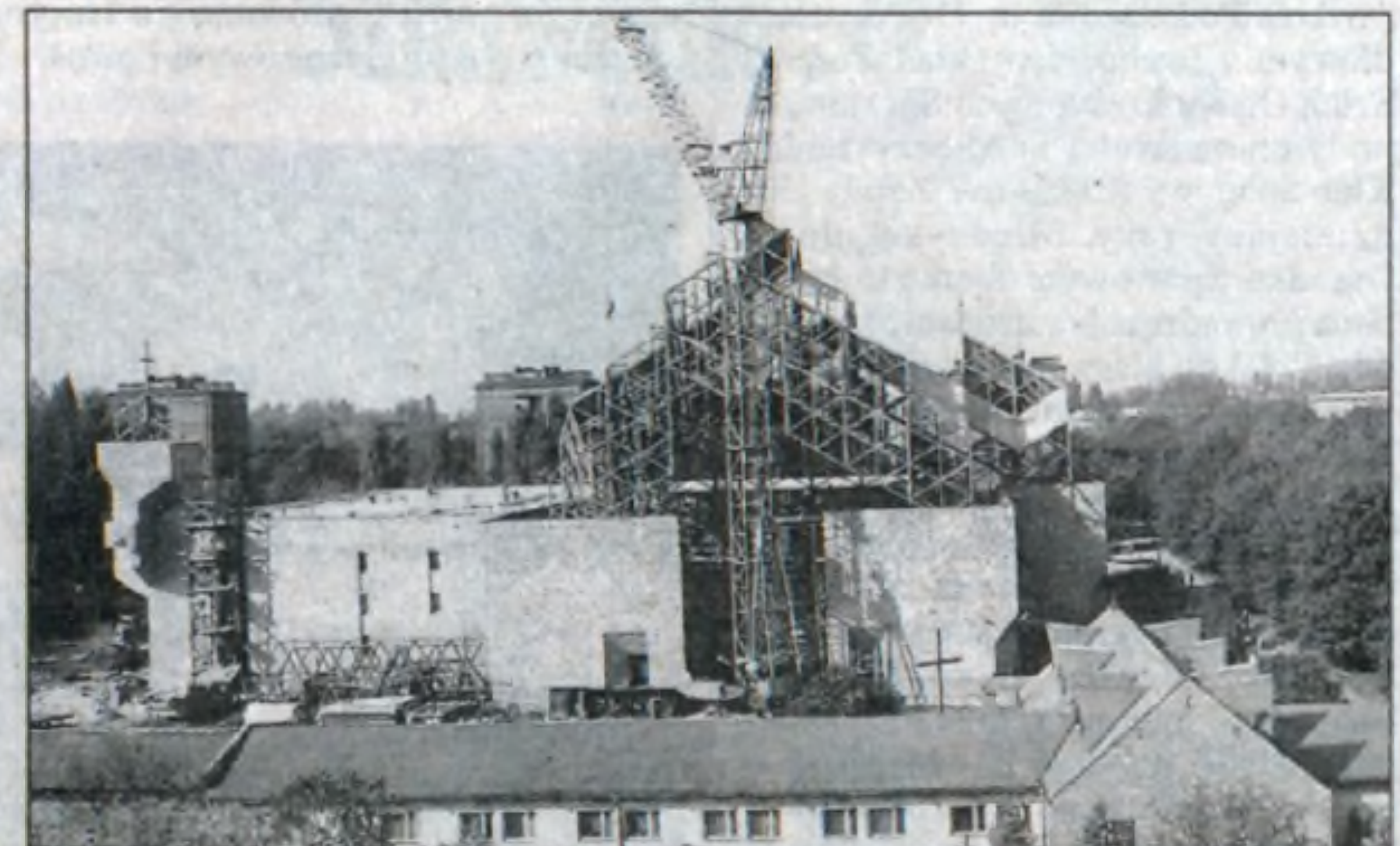
Montaż stalowej konstrukcji dachu kościoła na os. Szklane Domy, 1990–1991, aut. fot. niezna-ny, wł. archiwum parafii Matki Bożej Częstochowskiej.
