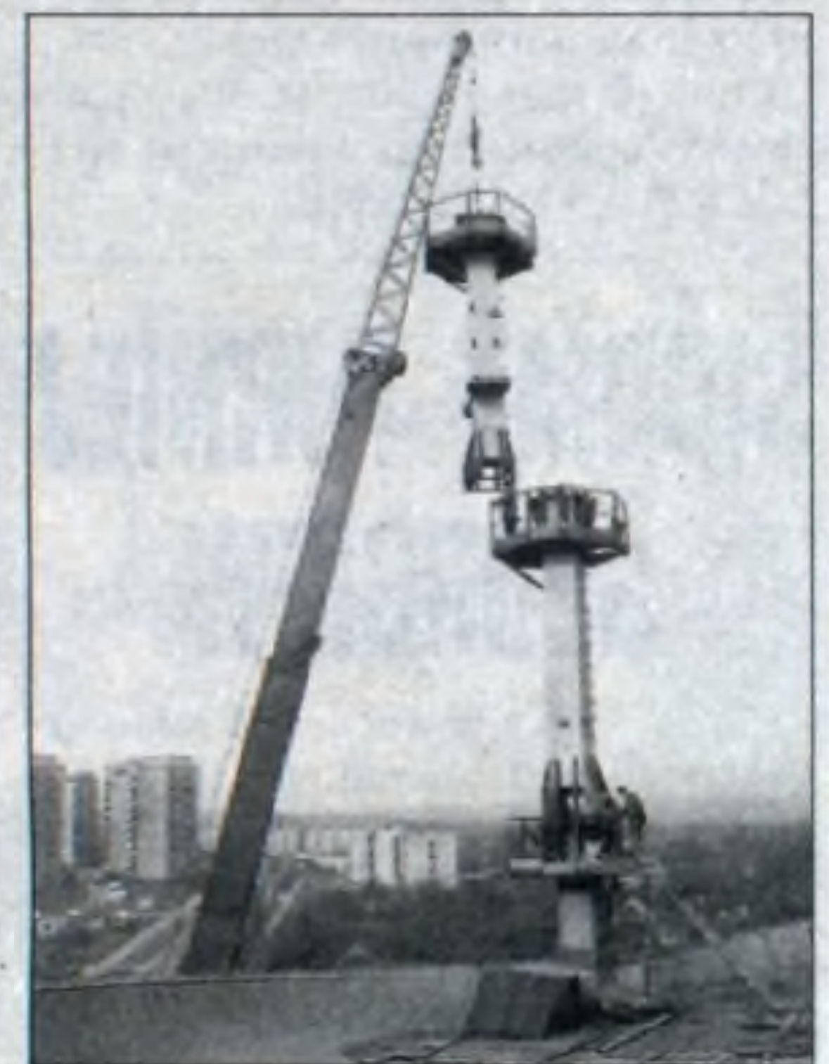
Ustawianie 75-metrowego krzyżamasztu na Arce Pana, około 15 listopada 1976 r., aut. fot. niezna-ny, arch. ks. prof. J. Szczepaniaka.
