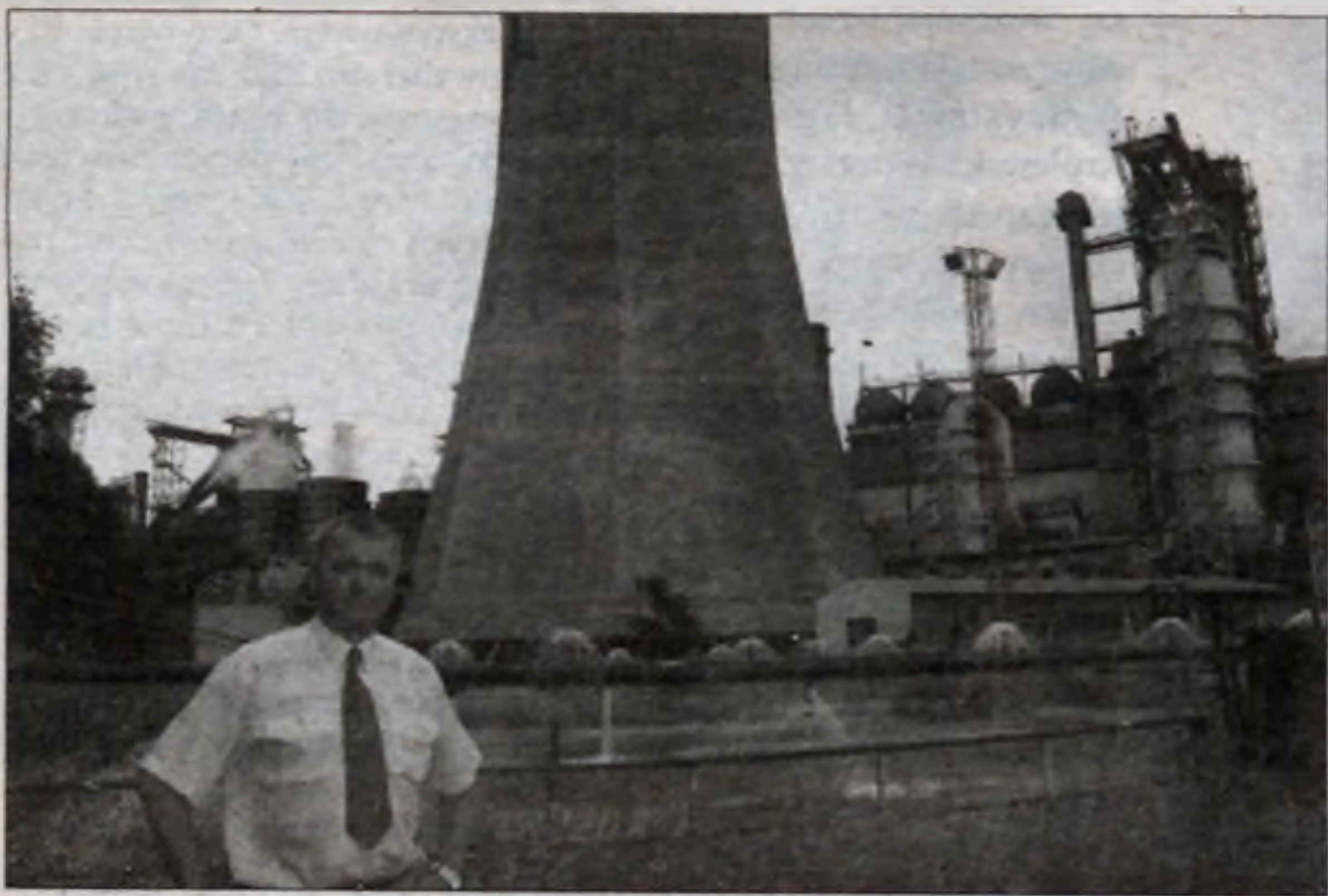
To żaden komin, to chłodnia wentylatorowa. Przed nią – Leszek Janiczak, kierownik wydziału wodnego Zakładu Energetycznego w Krakowie.
