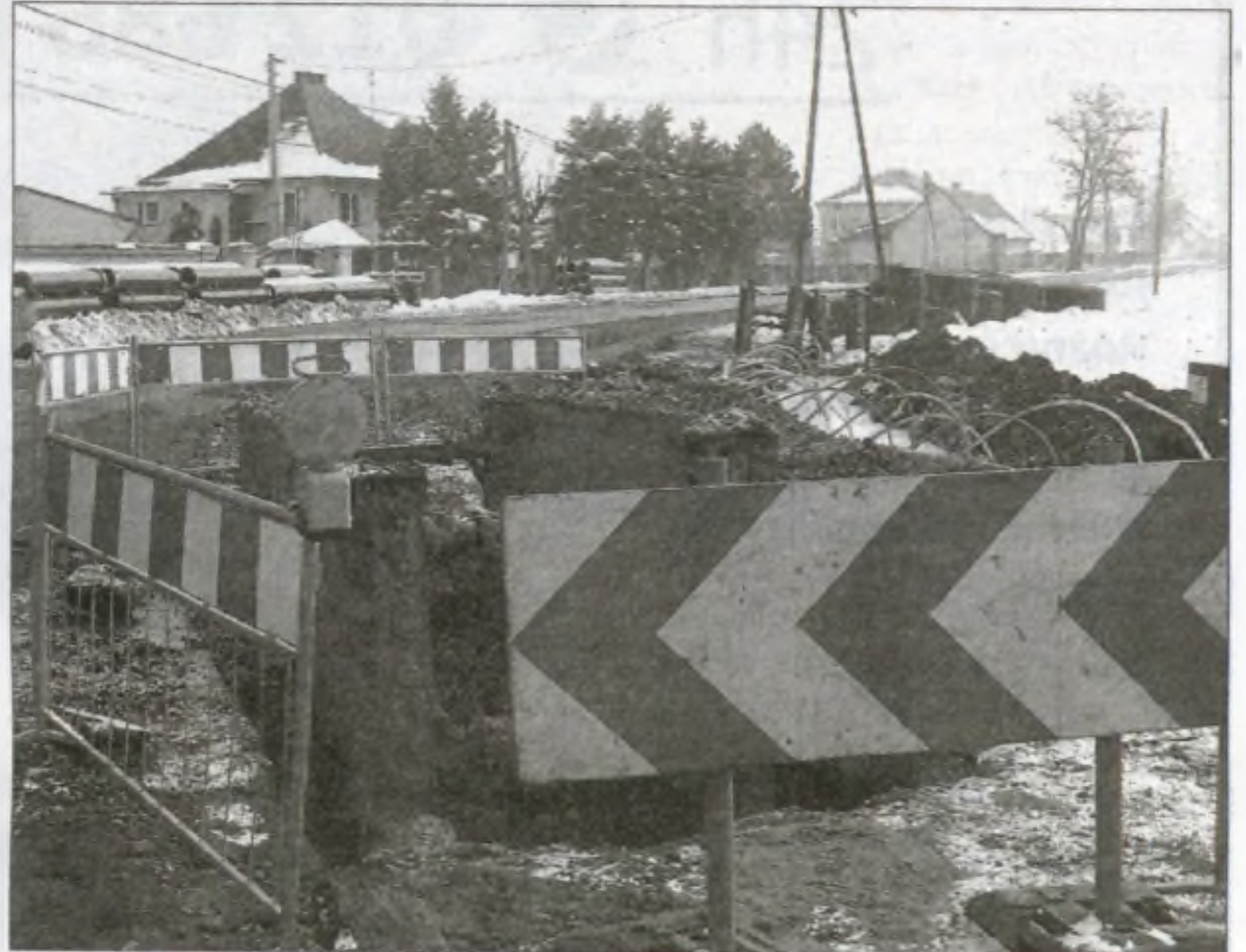
Budowa kolektora przez osiedle Przylasek Rusiecki.
