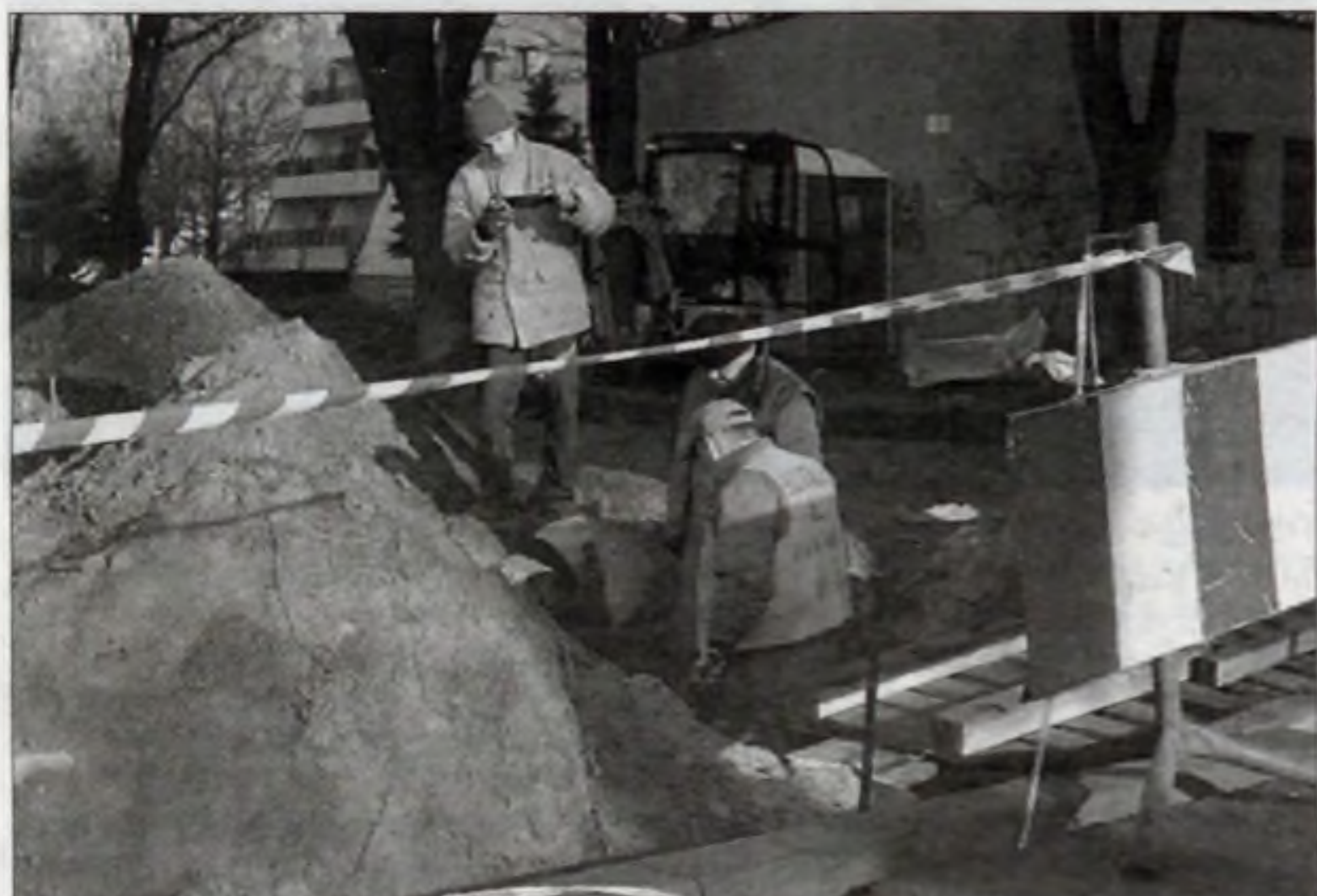
W grudniu przy ulicy Łokietkówny trwały intensywne prace budowlane.
