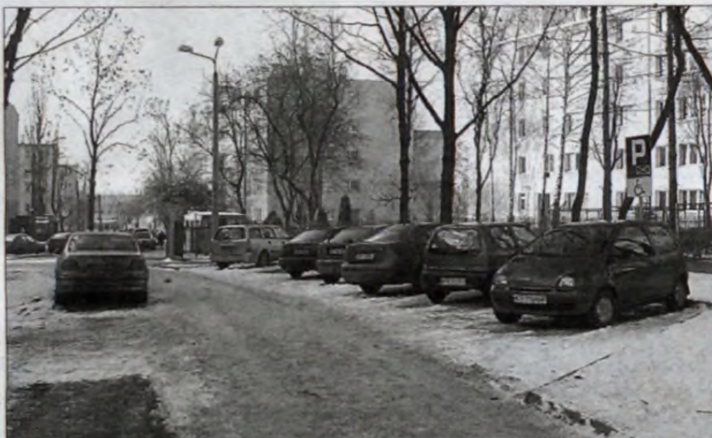
Przy ulicy Łokietkówny powstało 10 nowych miejsc parkingowych.
