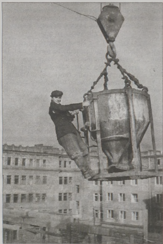
Budowa osiedla Hutniczego, 1952.
