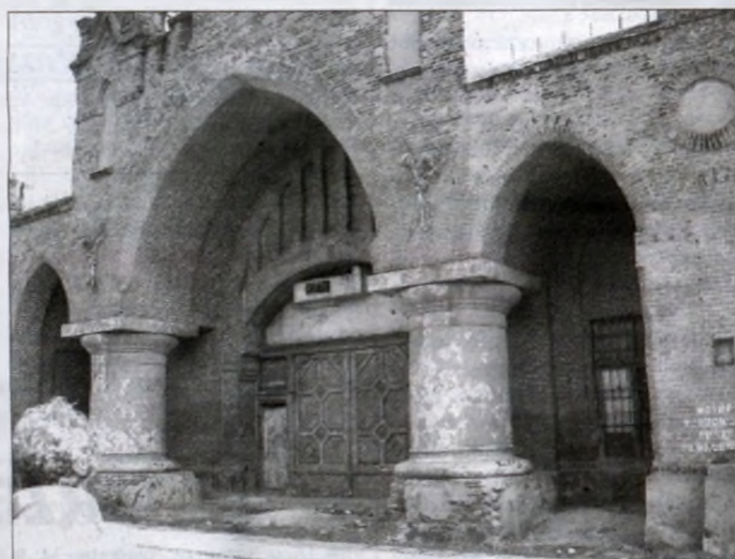
Tzw. „beczki Grohmann” – po dawnej fabryce pozostała okazała brama wejściowa. Budynki przemysłowe nie dotrwały do dzisiejszych czasów. Brama nawiązuje stylem do architektury gotyckiej. Sklepienie bramy wspiera ją dwie potężne kolumny potocznie nazywane „Beczkami Grohmannowskimi” – a to, gdy przyjrzeć się dokładnie – olbrzymie szpulki na nici.
