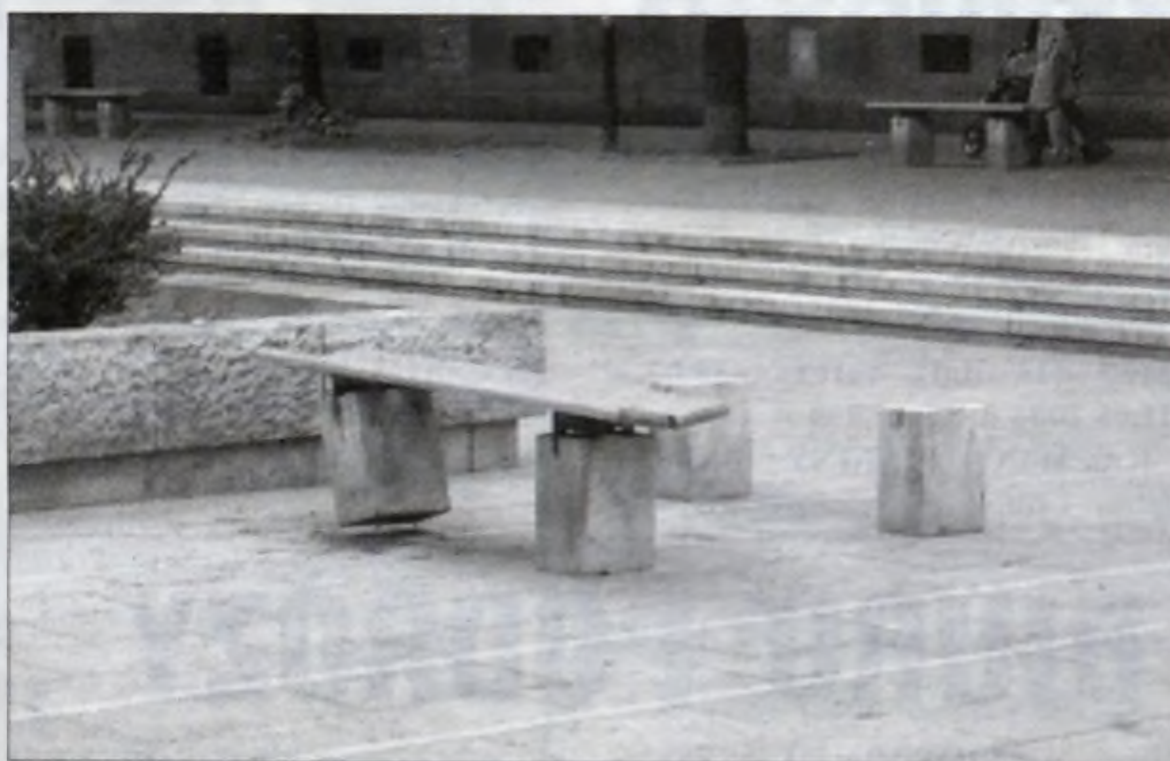
Zniszczone ławki przy klombie z krzewami.
