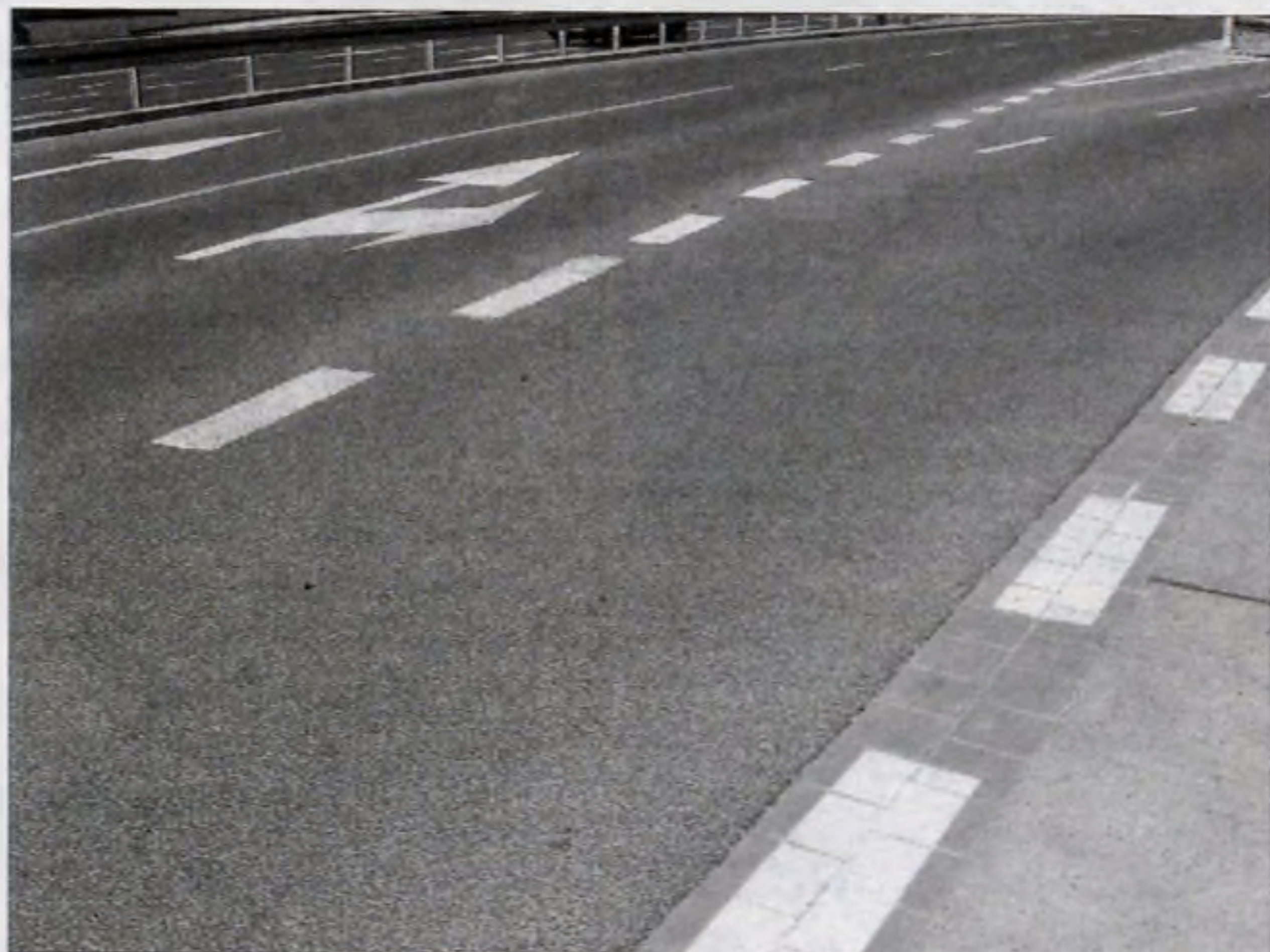
Wiadukt nad ulicą Wielicką został wykonany całkowicie z kruszyw wyprodukowanych w firmie Slag Recycling. Po kilku latach nawierzchnia wiaduktu jest w doskonałym stanie.
