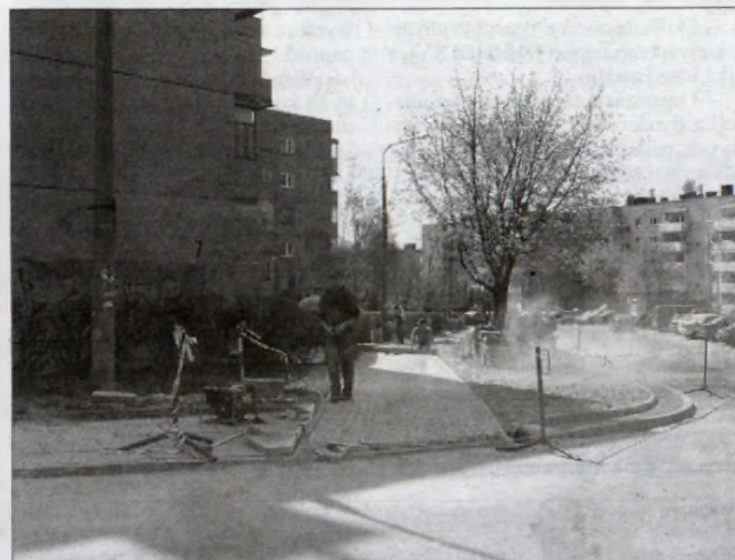
Remont chodnika przy ul. Zabłockiego”.
