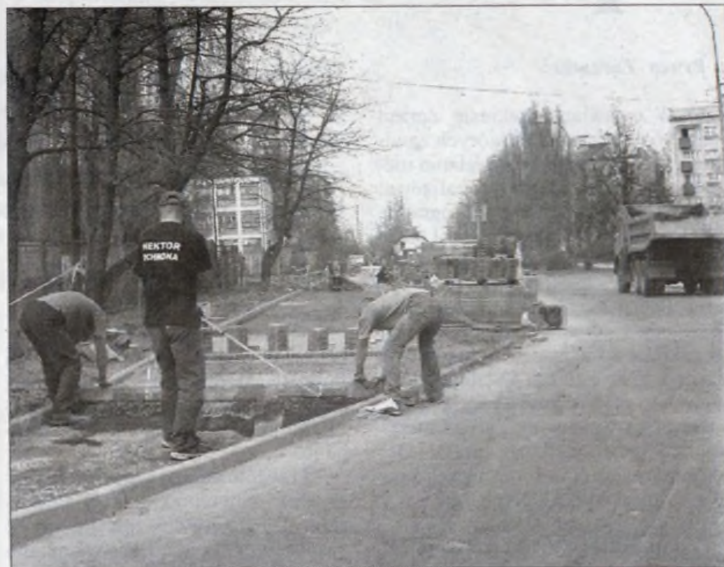
Remont chodnika przy ul. Miśnięskiej”.
