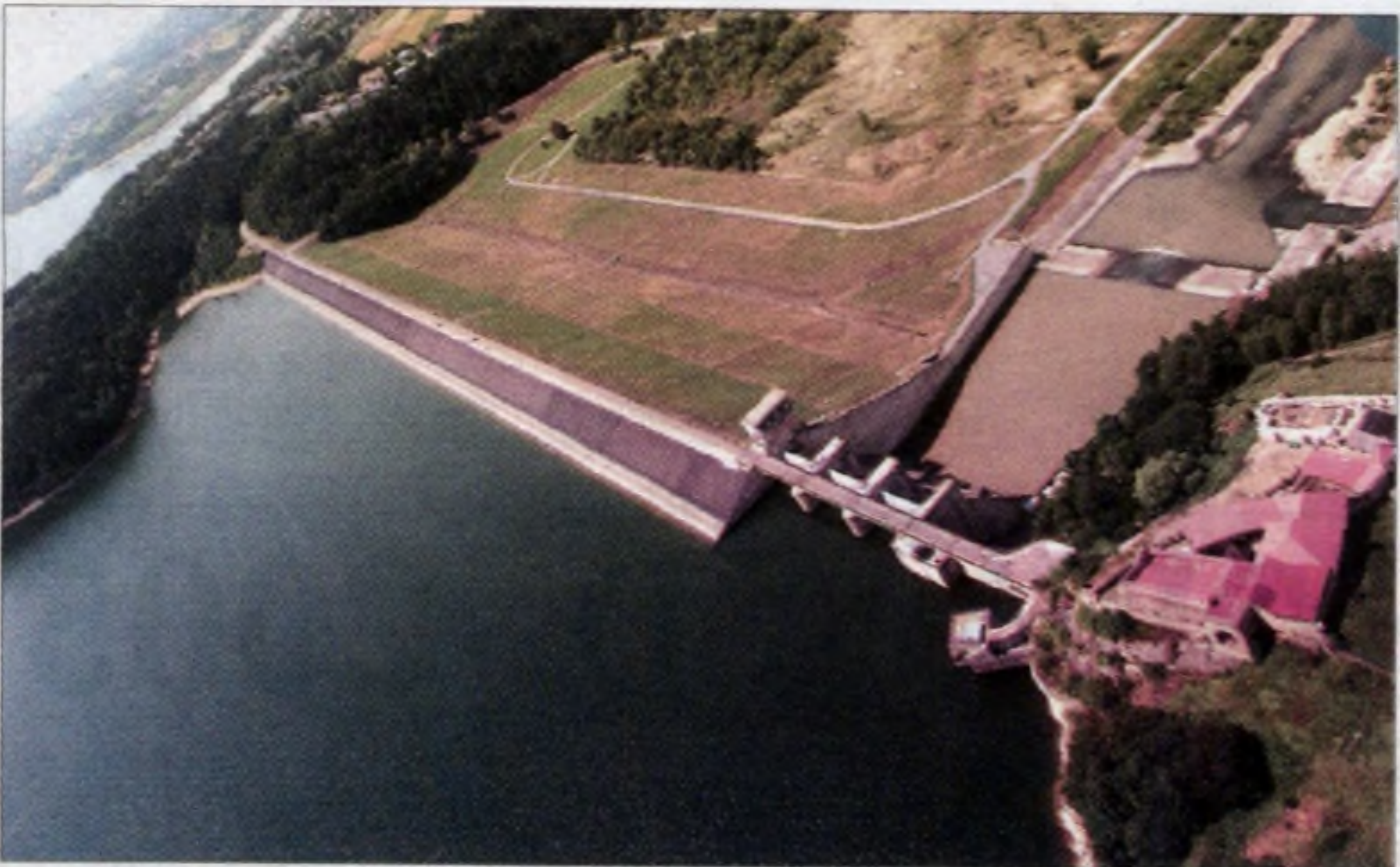
Zakład Uzdatniania Wody RABA
