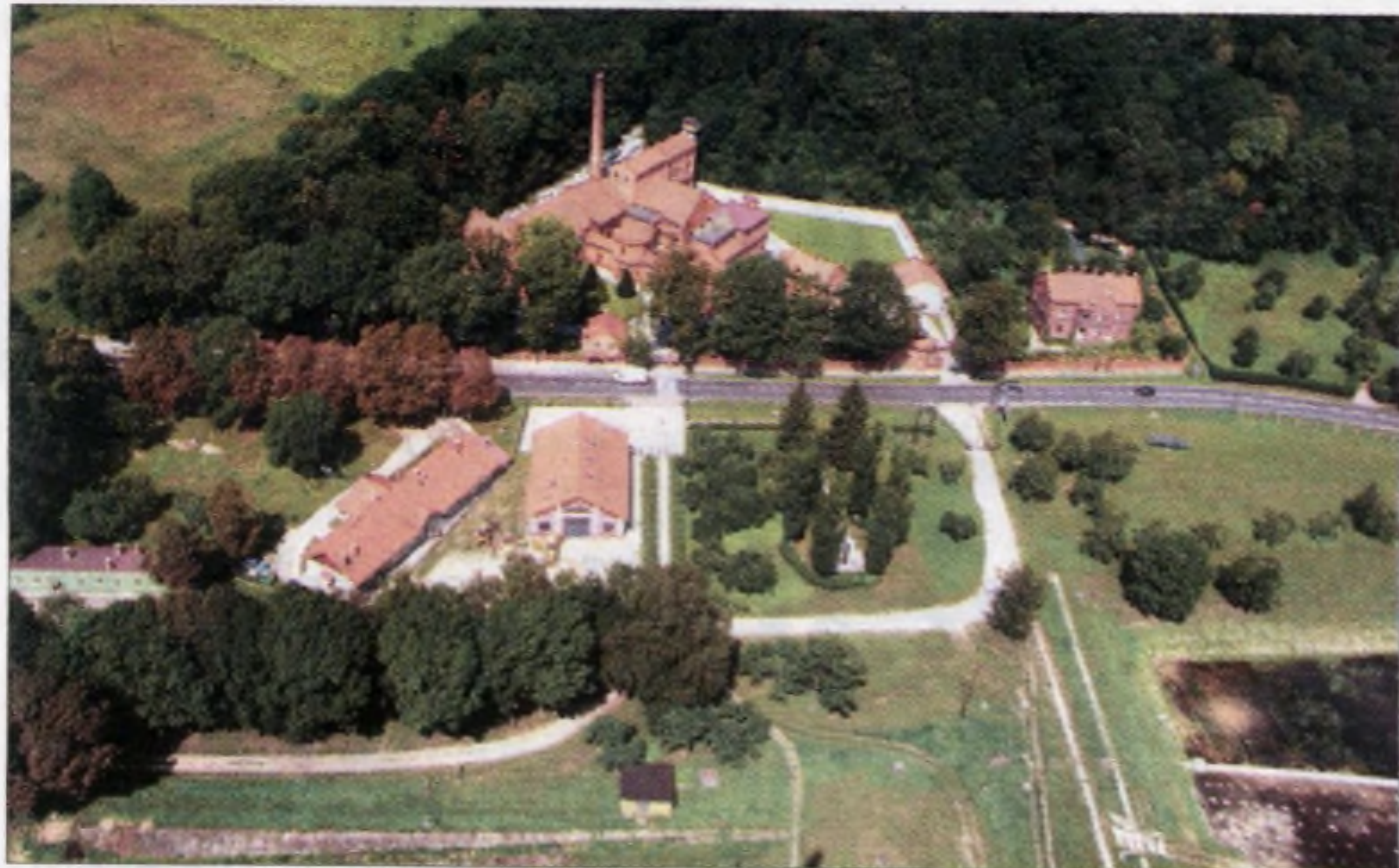
Zakład Uzdatniania Wody BIELANY
