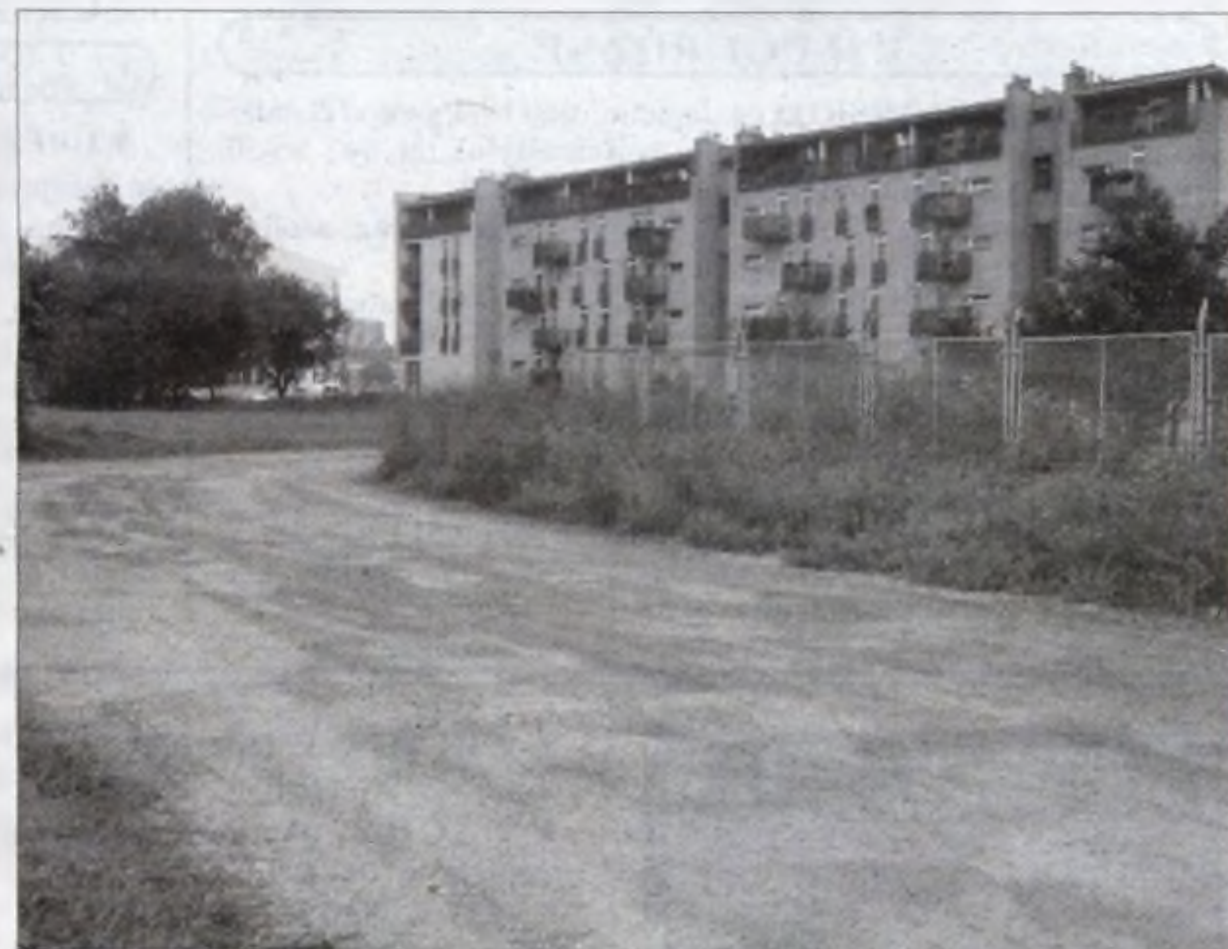
Nieoftejalny dojazd do bloków prowadzi przez działkę, z wykupieniem której inwestor zwleka od czasu zakończenia budowy. (fot. Jerzy Woźniakiewicz)
