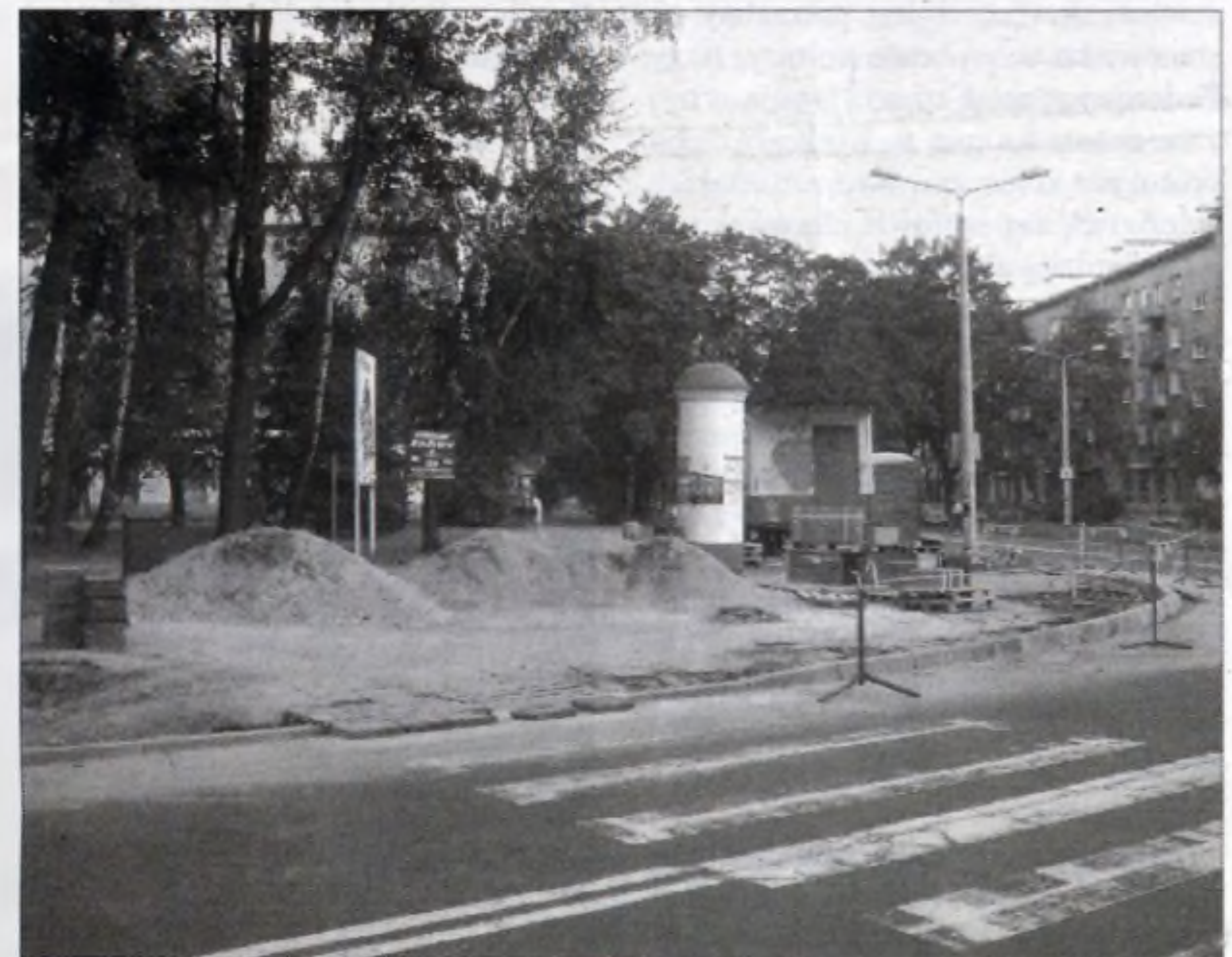
Przy os. Szkolnym. Trwa budowa nowej zatoki parkingowej.
