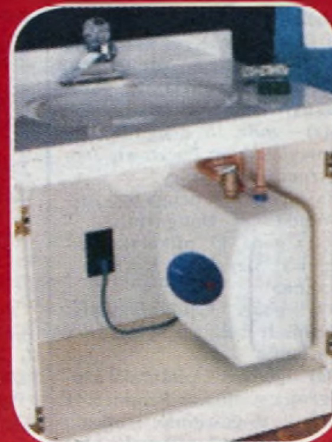
Rys. 3 – Mały podgrzewacz elektryczny TiShape zamontowany pod zlewem
