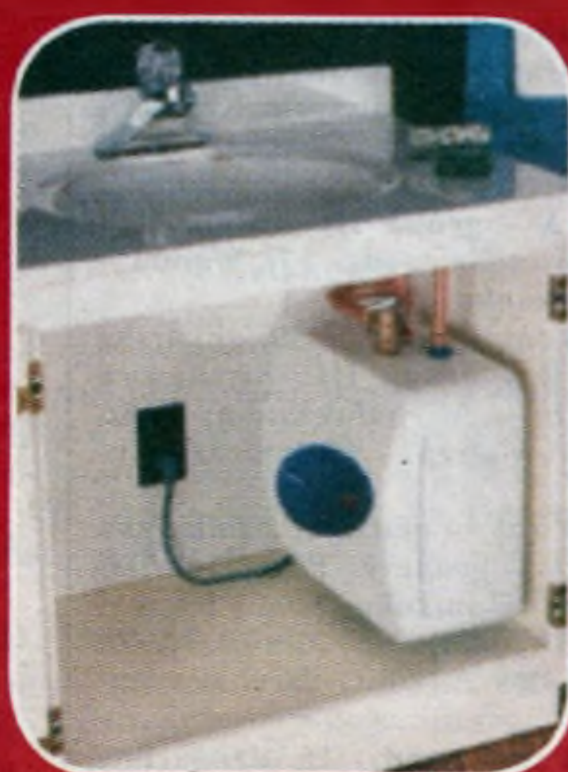
Rys. 3 – Mały podgrzewacz elektryczny TiShape zamontowany pod zlewem
