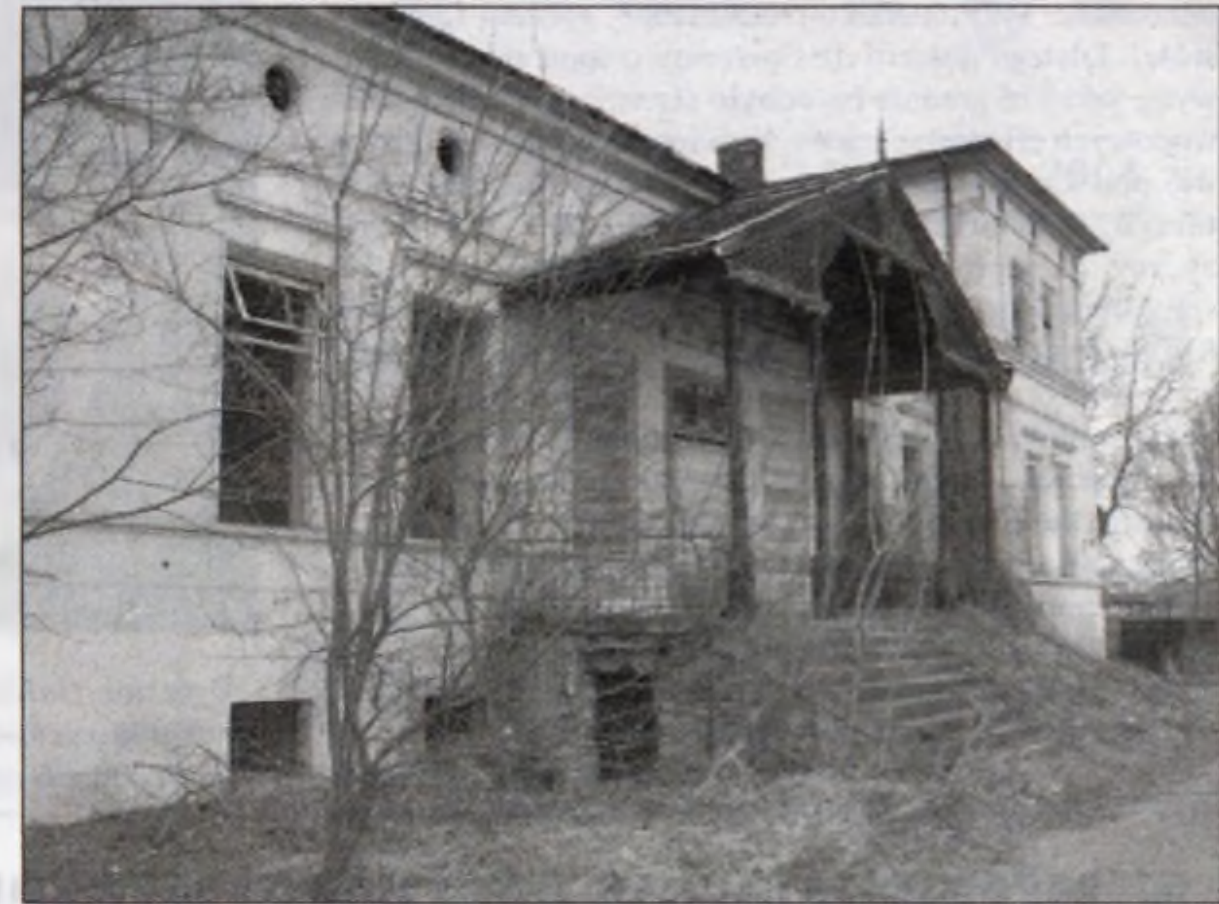
Pałac w Kościelnikach odzyskał właścicieli i nadzieję na podniesienie z ruiny.
