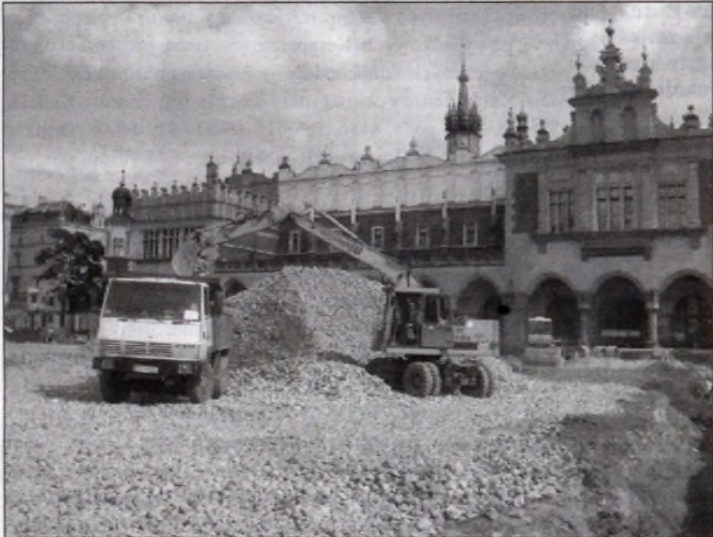
Kruszywo z firmy Slag Recycling zajmującej się likwidacją hałdy hutniczej w Pleszowie trafia nie tylko na autostrady. Tego lata posłużyło do utwardzania powierzchni Krakowskiego Rynku.
