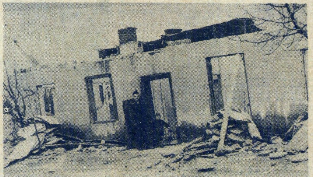
Barak w trakcie rozbiórki
