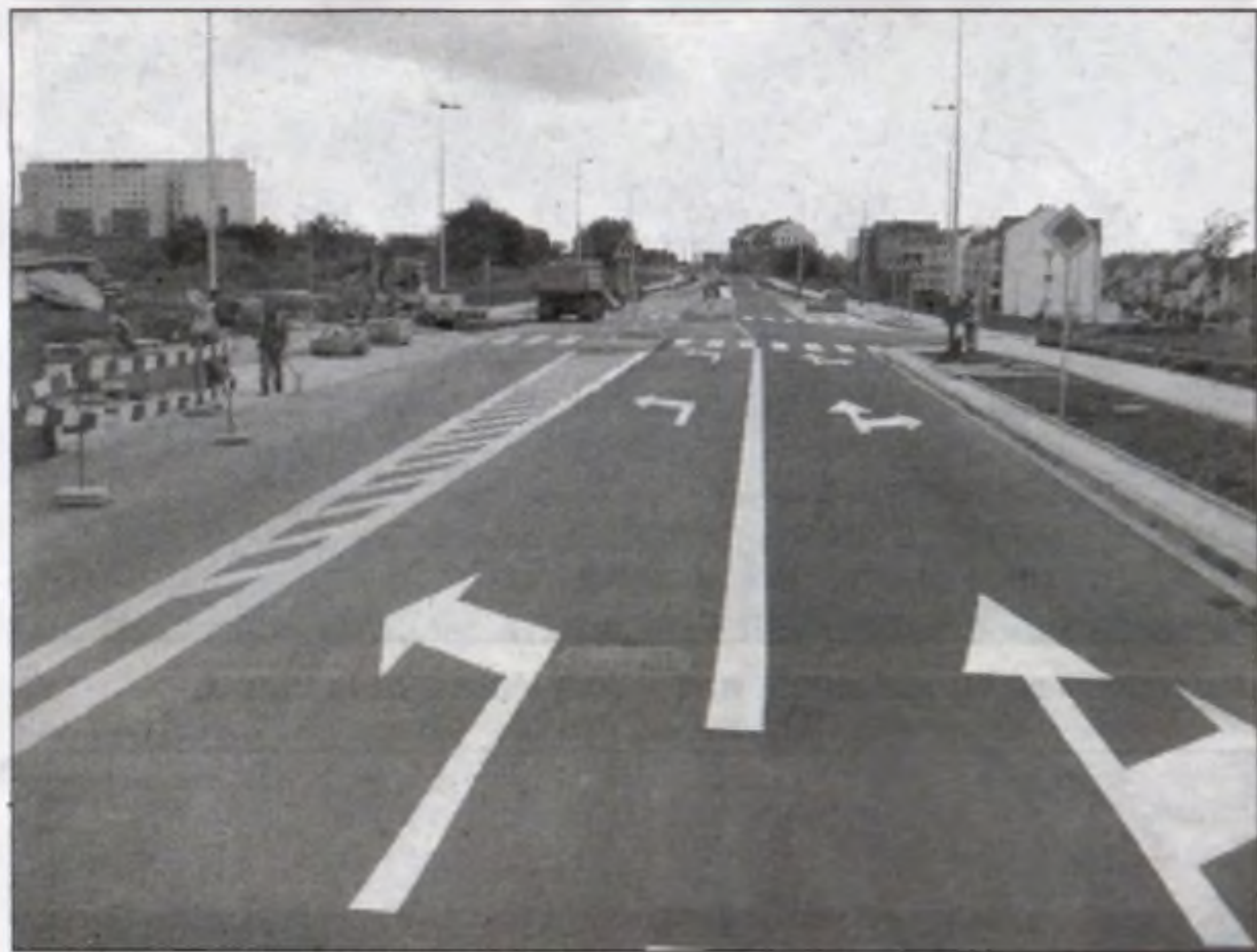
Już wkrótce końcowy odbiór inwestycji.
