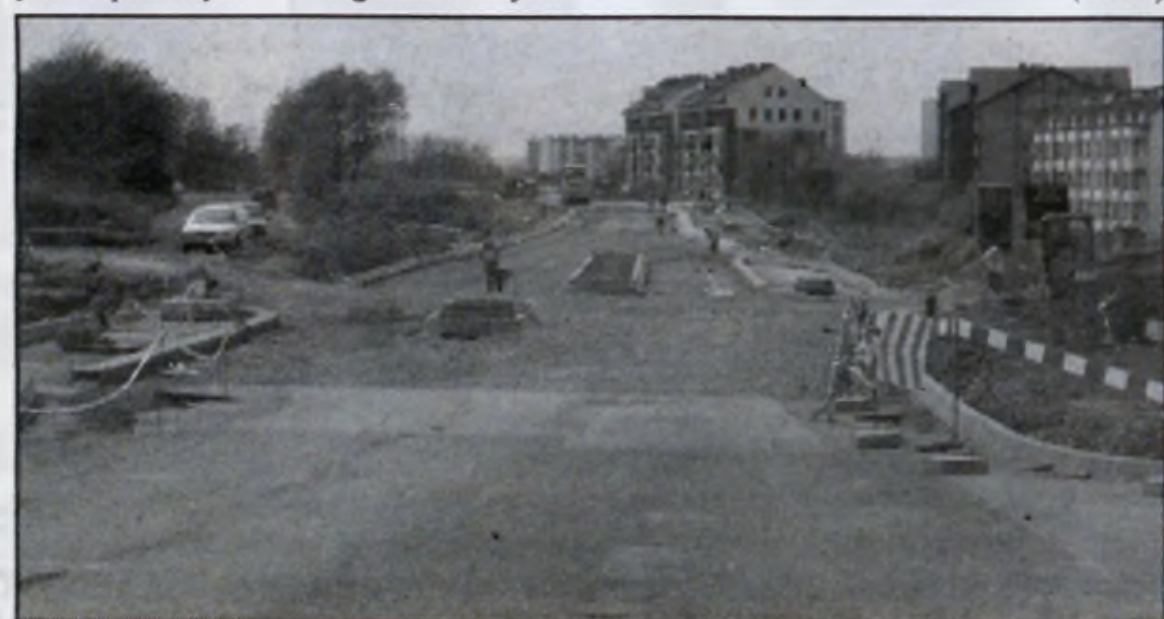
Budowa połączenia ul. Ks. Jancarza z ul. Ks. Kurzei.
