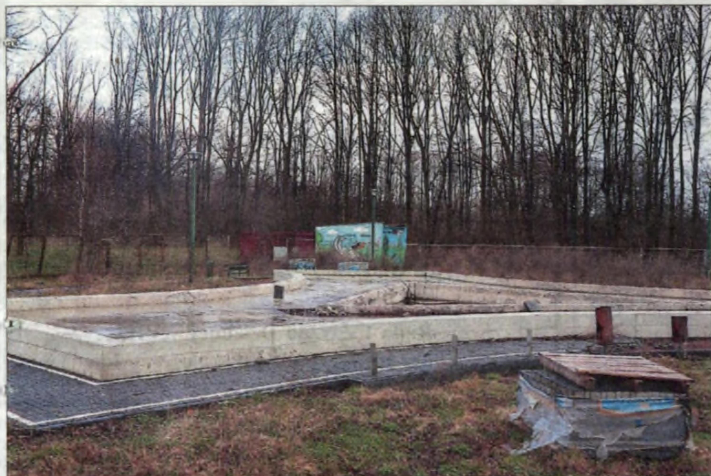
W tym miejscu powstanie tężnia solankowa.
