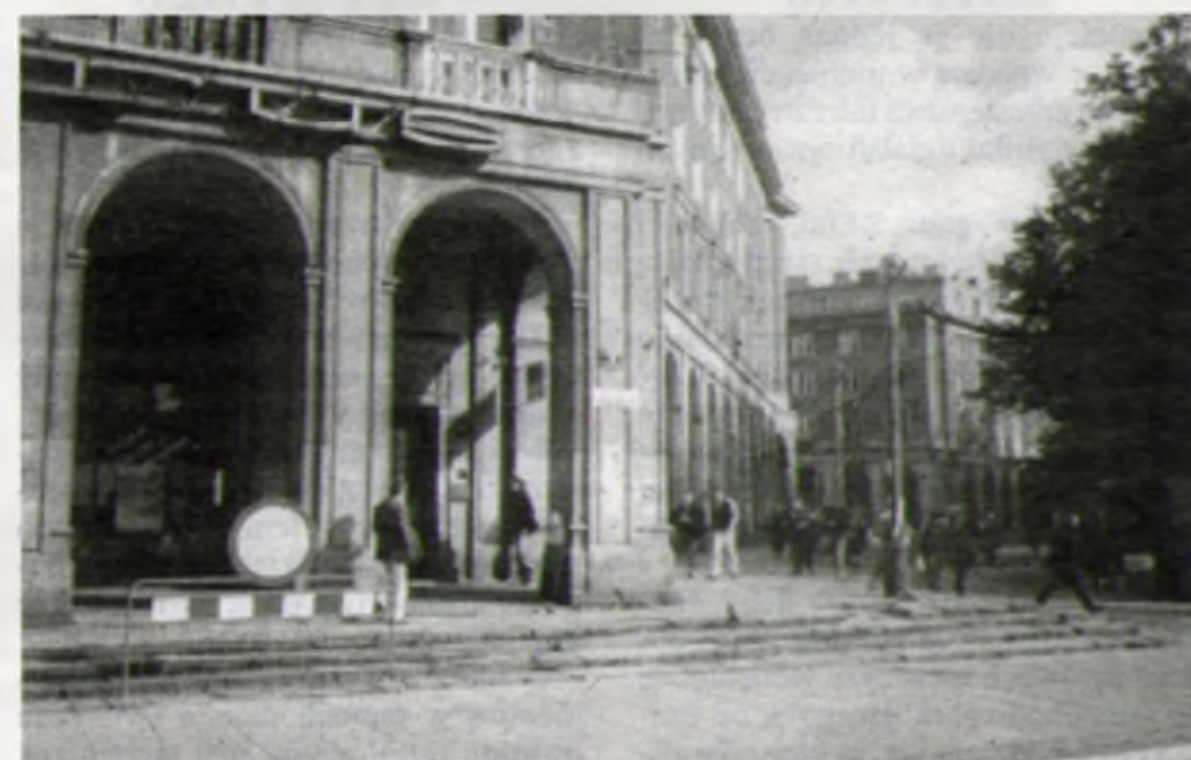
Ustawianie znaków zakazu ruchu nie rozwiązuje problemu.
