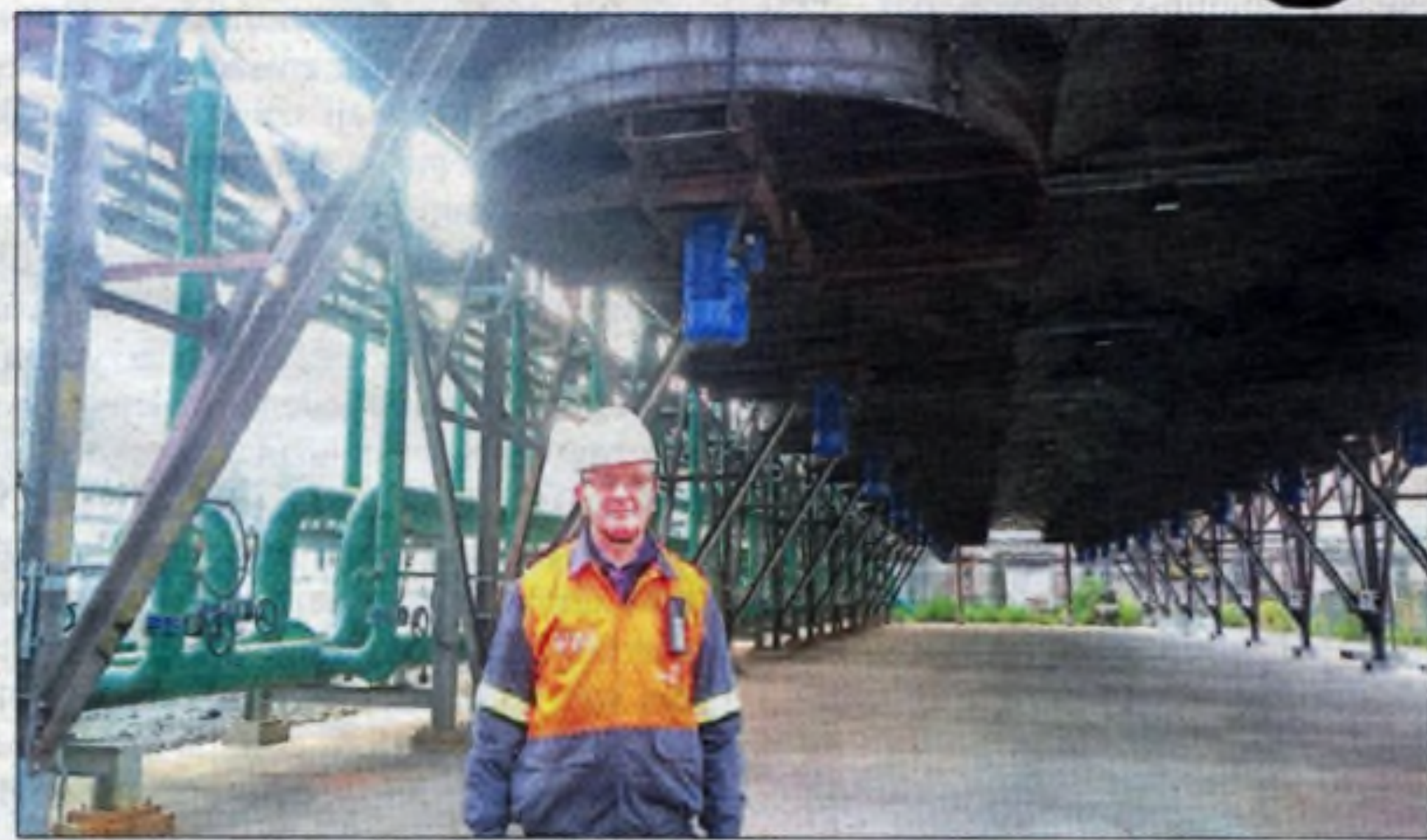
Chłodzenie wielkiego pieca jest wspomagane przez 20 wentylatorów.
