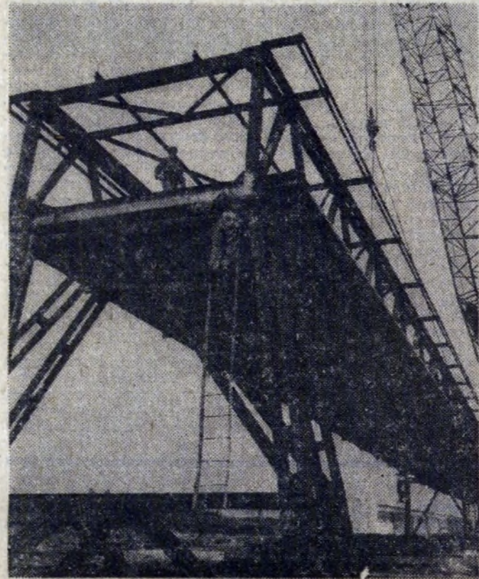
Koksownia — montaż estakady, która transportowany będzie koks dla wielkich pieców Huty Katowice. Fot. MIROSLAW NOWORYTA
