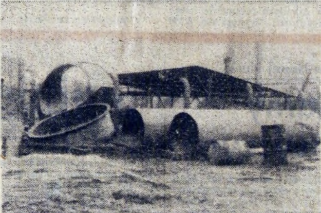
Tak wygląda składowisko materiałów budowlanych, złomu żelaza i różnego rodzaju odpadów przy drodze do ZO. Najwyższy czas, aby w ramach wiosennych porządków zająć się również tym placem!
