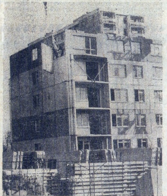
Ostatnie bloki budowane w zespole Osiedla Piastów. Fot. J. WCISŁO
