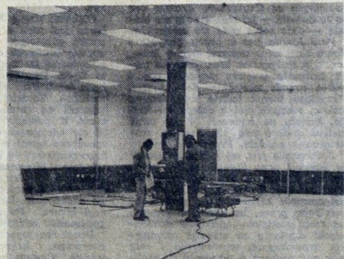
W tym pomieszczeniu montowane będą nowe komputery.
